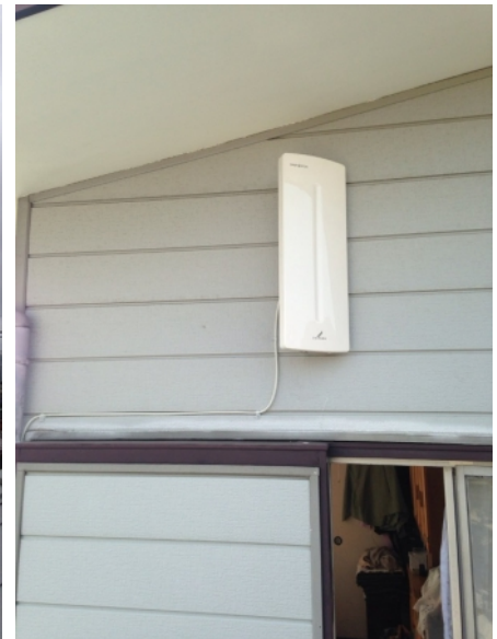
川崎市宮前区宮崎 壁面取付 デザインアンテナ 工事
