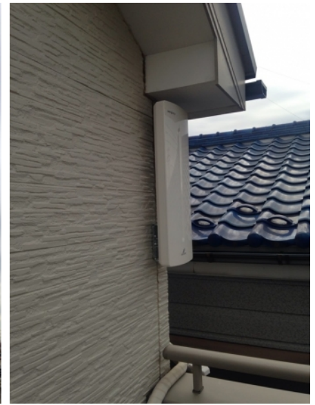
川崎市宮前区馬絹 壁面取付 デザインアンテナ 工事
