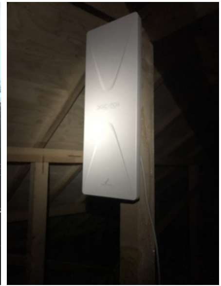
川崎市宮前区水沢 東日本ハウジング様物件 デザインアンテナ屋根裏工事
