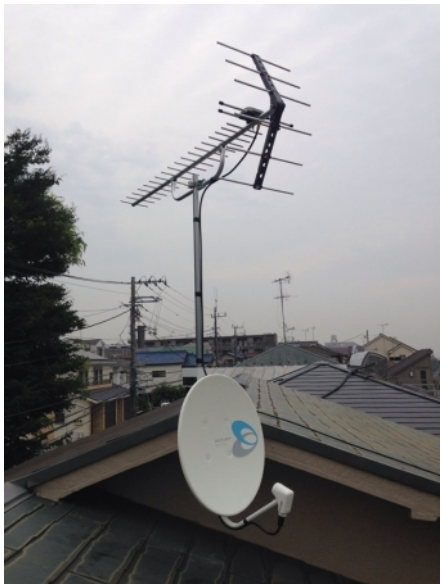
川崎市宮前区野川 壁面取付 地デジアンテナとBSアンテナ工事
