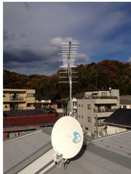
川崎市宮前区神木本町 地デジアンテナとBSアンテナ工事
