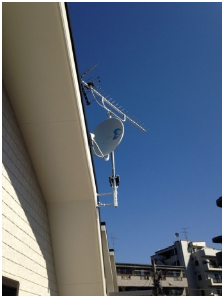
川崎市宮前区有馬 壁面取付 地デジアンテナとBSアンテナ工事
