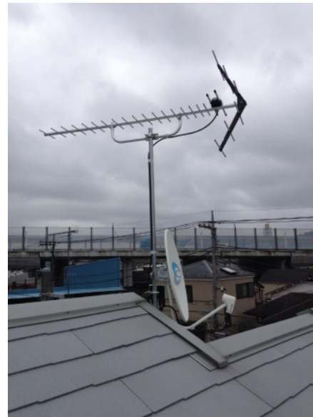
川崎市宮前区神木本町 壁面取付 地デジアンテナとBSアンテナ工事
