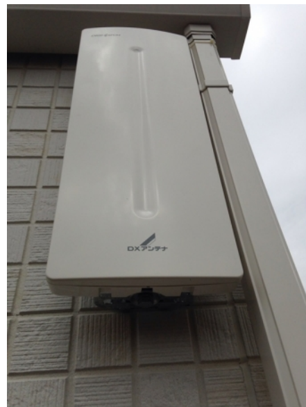
川崎市宮前区菅生 ホームセンター様物件 壁面取付 デザインアンテナ工事
