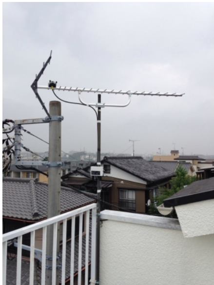
川崎市宮前区馬絹 バランダ取付 地デジアンテナ 工事
