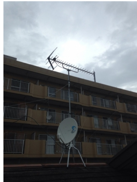
川崎市宮前区有馬 地デジアンテナとBSアンテナ屋根上工事
