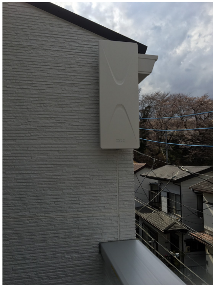
川崎市宮前区有馬 壁面取付 デザインアンテナ工事
