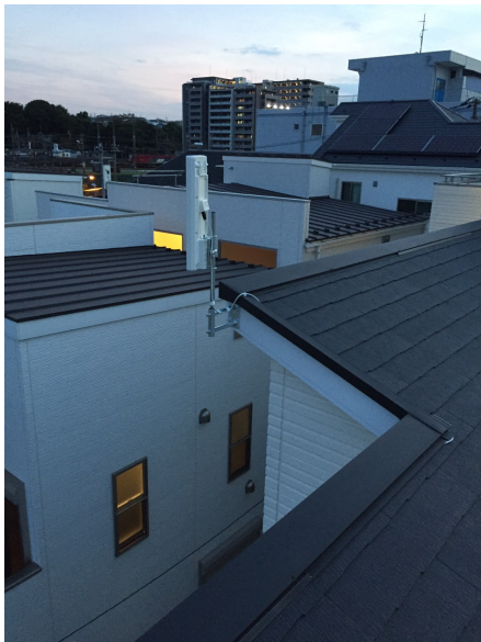
川崎市宮前区梶ヶ谷 アゼリアホーム様物件 壁面取付 デザインアンテナ工事
