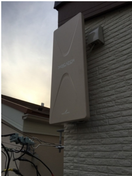
川崎市宮前区菅生 東日本ハウジング様物件 壁面取付 デザインアンテナ工事
