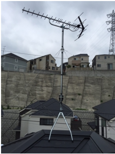
川崎市宮前区野川 津久見建設様物件 地デジアンテナ屋根上工事
