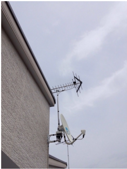
川崎市宮前区菅生ヶ丘 ハートフルホーム様物件 壁面取付 地デジアンテナとBSアンテナ工事
