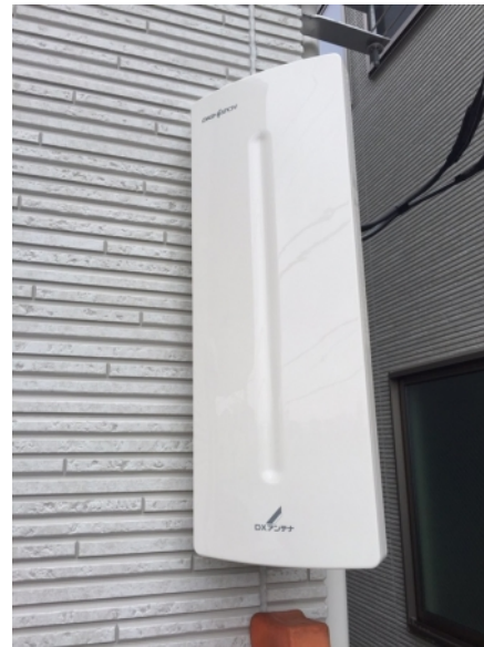
川崎市宮前区久地 ひかり建設様物件 壁面取付 デザインアンテナ工事
