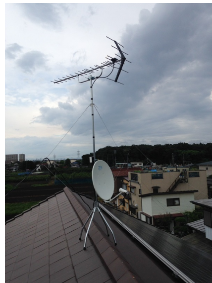
藤沢市長後 地デジアンテナとBSアンテナ屋根上工事
