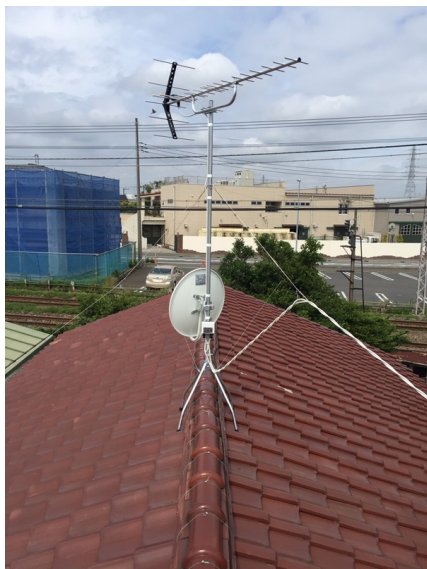
藤沢市亀井野 地デジアンテナとBSアンテナ屋根上工事
