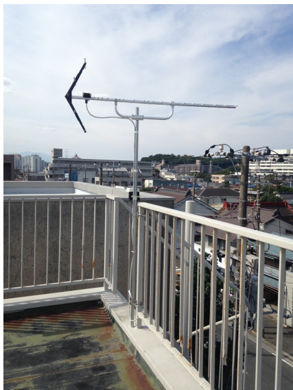
藤沢市本町 手すり取付 地デジアンテナ工事
