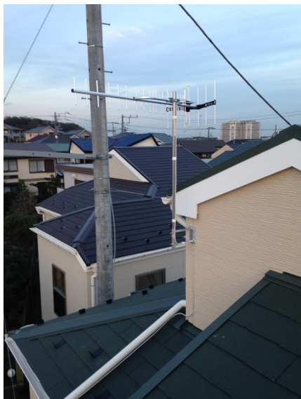
藤沢市村岡東 垂直偏波受信 壁面取付 地デジアンテナ工事
