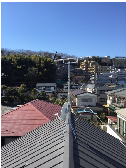
藤沢市辻堂 垂直偏波受信 地デジアンテナの屋根上設置
