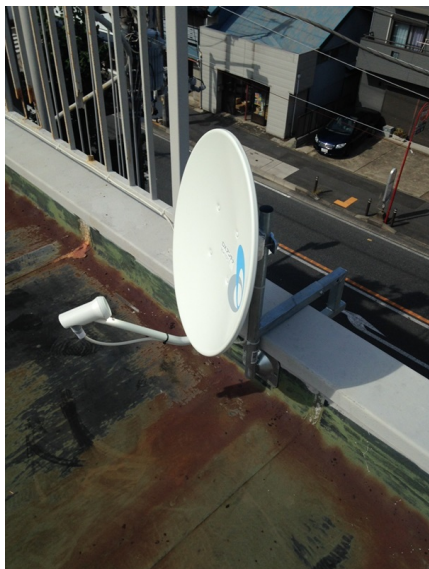
藤沢市本町 挟み込み取付 BSアンテナ工事
