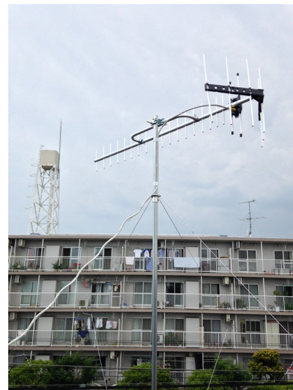
藤沢市長後 垂直偏波受信 地デジアンテナ屋根 上工事
