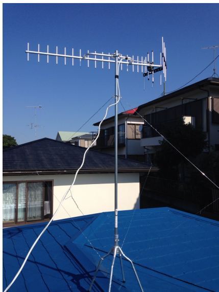
藤沢市大鋸 垂直偏波受信 地デジアンテナ屋根上工事
