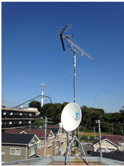
藤沢市立石 地デジアンテナとBSアンテナ屋根上工事
