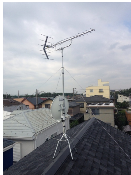
藤沢市鵠沼海岸 地デジアンテナとBSアンテナ屋根上工事
