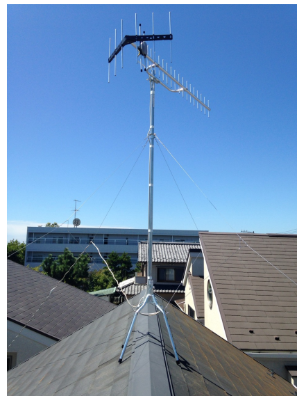
藤沢市辻堂 垂直偏波受信 地デジアンテナ屋根上工事
