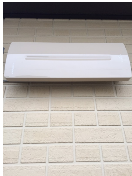
藤沢市柄沢 ダイワハウス様物件 垂直偏波受信 壁面取付 デザインアンテナ工事
