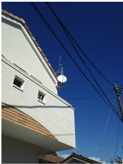
藤沢市菖蒲沢 イーカム様物件 垂直偏波受信 壁面取付 地デジアンテナとB Sアンテナ工事
