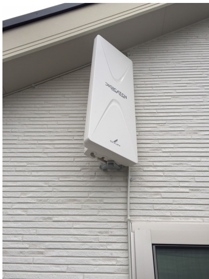
藤沢市大庭 東栄住宅様物件 壁面取付 デザインアンテナ工事
