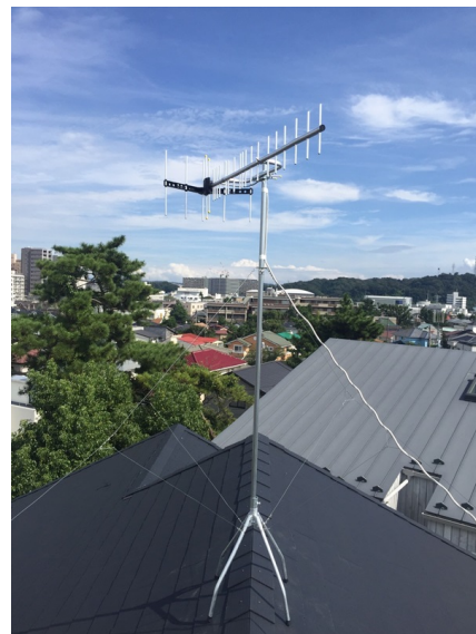
藤沢市鵠沼橋 三井ホーム様物件 垂直偏波受信 地デジアンテナ屋根上工事
