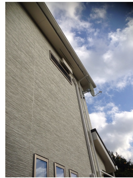
藤沢市鵠沼桜が岡 一建設様物件 垂直偏波受信 壁面取付 デザインアンテナとB Sアンテナ工事
