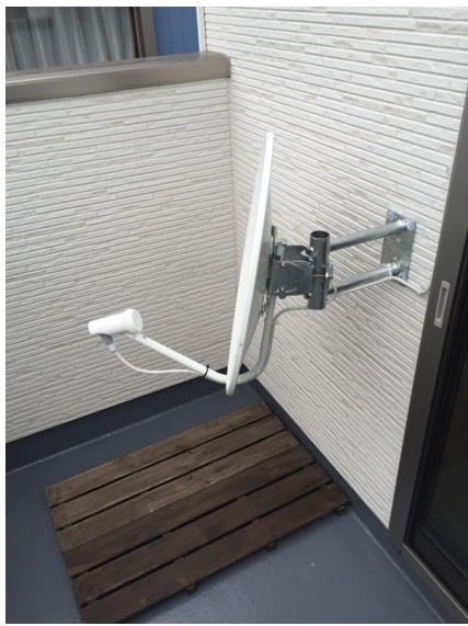
藤沢市大庭 東栄住宅様物件 壁面取付 B Sアンテナ工事
