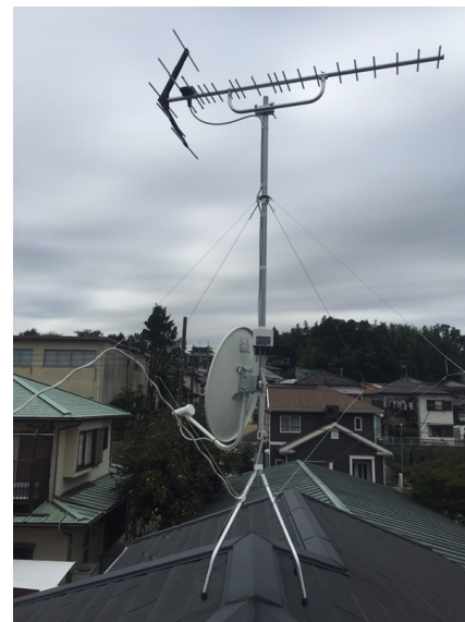
藤沢市大鋸 一建設様物件 地デジアンテナとB Sアンテナ屋根上工事
