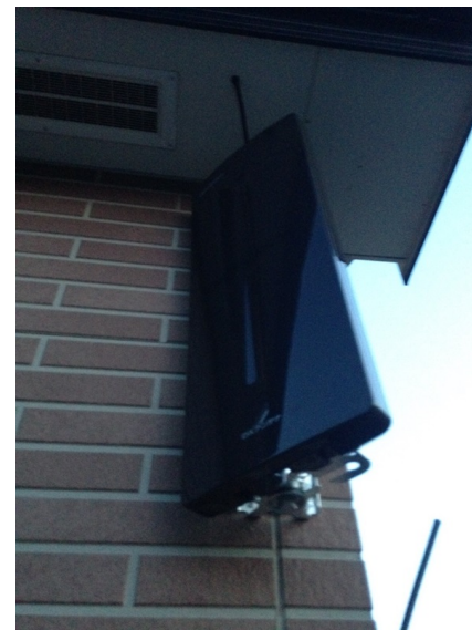
藤沢市長後 壁面取付 デザインアンテナ工事
