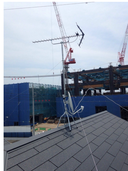
藤沢市土棚 地デジアンテナとBSアンテナ屋根上工事
