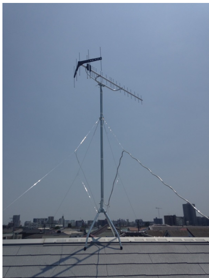
藤沢市高倉 一平不動産様物件 垂直偏波受信 地デジアンテナ屋根上工事
