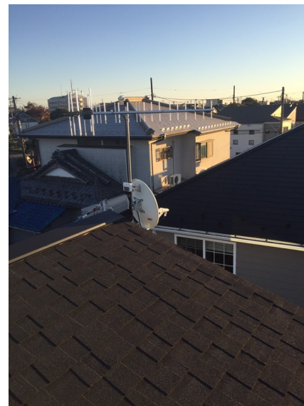
藤沢市本鵠沼 垂直偏波受信 壁面取付 地デジアンテナとBSアンテナ工事
