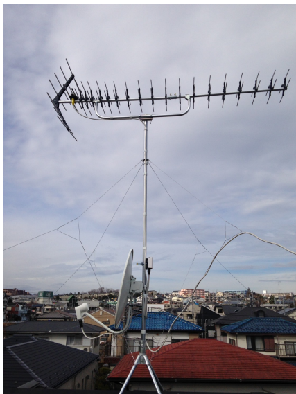
藤沢市本藤沢 屋根上設置 高性能八木式アンテナとBS/CSアンテナ工事
