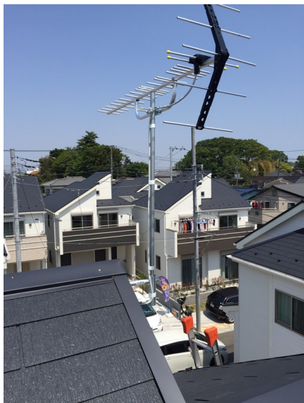
藤沢市亀井野 東栄住宅様物件 壁面取付 地デジアンテナ工事
