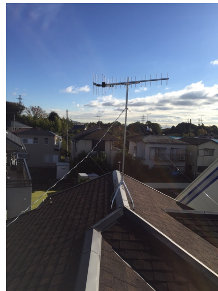
藤沢市高倉 垂直偏波受信 地デジアンテナ屋根上工事
