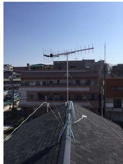
藤沢市大鋸 アーネストワン様物件 垂直偏波受信 地デジアンテナとBSアンテナ屋根上工事
