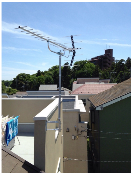
藤沢市石川 壁面取付 地デジアンテナ工事
