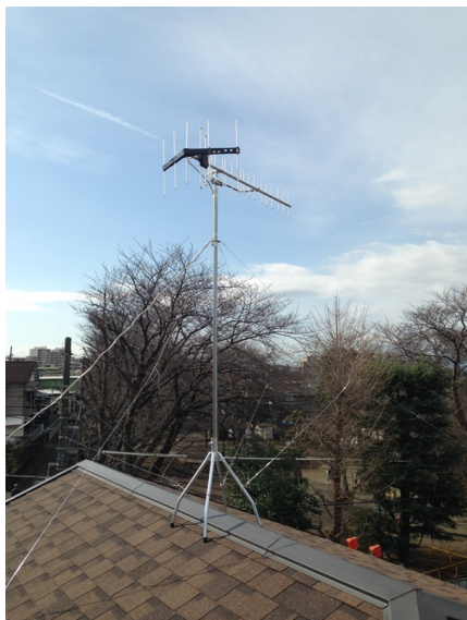
藤沢市藤が丘 住宅情報館様物件 垂直偏波受信 地デジアンテナ屋根上工事
