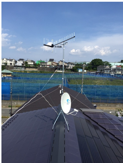
藤沢市西富 積水ハウス様物件 垂直偏波受信 地デジアンテナ屋根上工事
