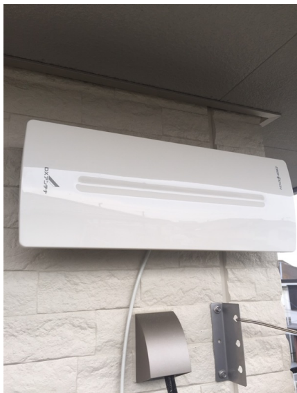
藤沢市片瀬山 ダイワハウス様物件 垂直偏波受信 壁面取付 デザインアンテナ工事
