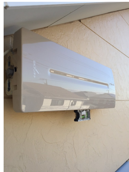
藤沢市稲荷 垂直偏波受信 壁面取付 デザインアンテナ工事
