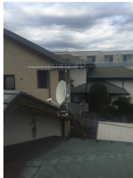
平塚市龍城が丘 垂直偏波受信 壁面取付 地デジアンテナとBSアンテナ工事
