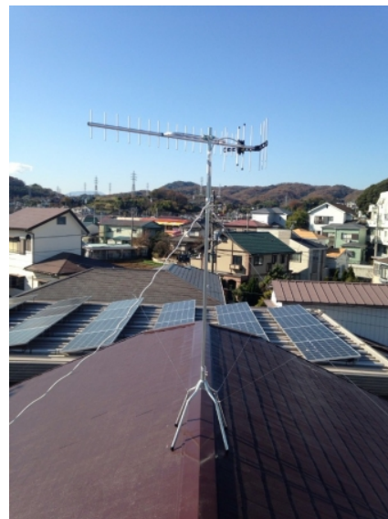
平塚市万田 垂直偏波受信 地デジアンテナ屋根上工事
