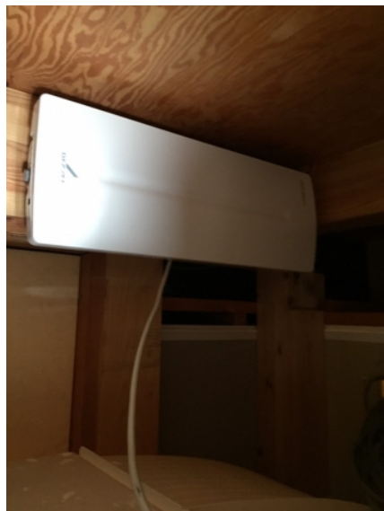
平塚市御殿 垂直偏波受信 デザインアンテナ屋根裏工事
