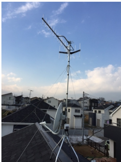
平塚市めぐみが丘 垂直偏波受信 地デジアンテナとBSアンテナ屋根上工事
