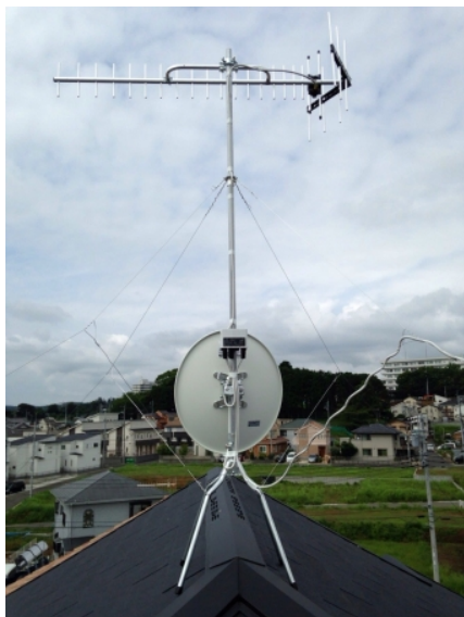
平塚市北金目 垂直偏波受信 地デジアンテナとBSアンテナ屋根上工事
