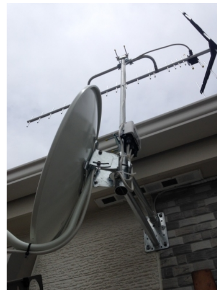
平塚市富士見町 壁面取付 地デジアンテナとBSアンテナ工事
