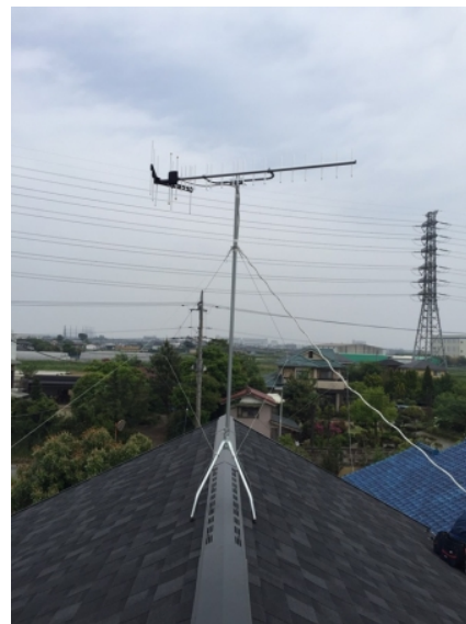
平塚市大島 垂直偏波受信 地デジアンテナ屋根上工事
