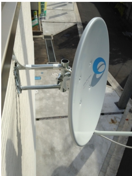
平塚市万田 一建設様物件 壁面取付 B S アン テナ工事
