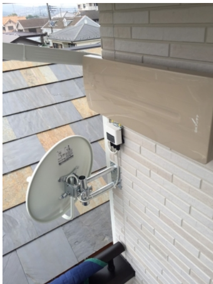
平塚市南原 富士住建様物件 垂直偏波受信 壁面取付 デザインアンテナとBSアンテナ工事
