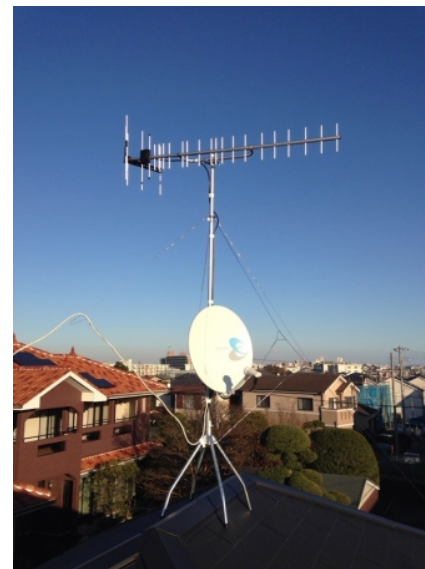
平塚市万田 一建設様物件 垂直偏波受信 地デジアンテナと B S アンテナ屋根上工事
