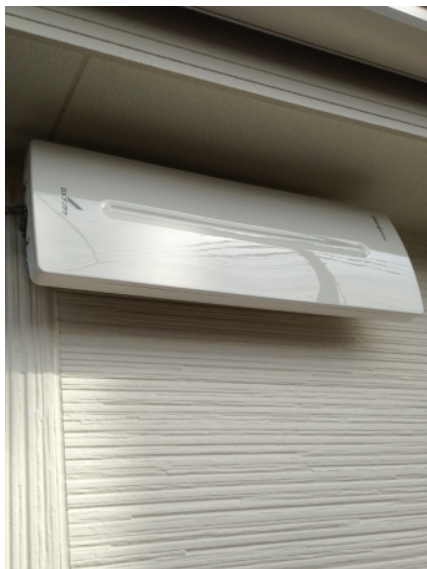
平塚市万田 一建設様物件 垂直偏波受信 壁面取付 デザインアンテナ工事
