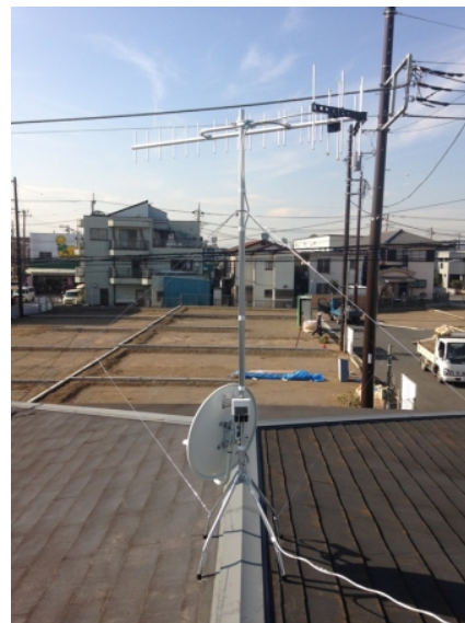
平塚市西八幡 地デジアンテナとBSアンテナ工 事
