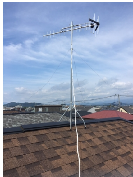
平塚市諏訪町 垂直偏波受信 地デジアンテナ屋根上工事
