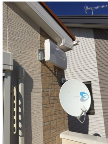
平塚市真田 垂直偏波受信 壁面取付 デザインアンテナとBSアンテナ工事
