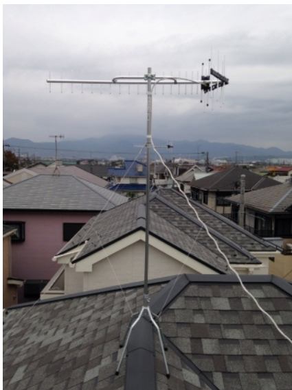
平塚市大神 垂直偏波受信 地デジアンテナ屋根上工事
