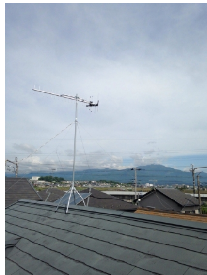
平塚市纏 垂直偏波受信 地デジアンテナ屋根上 工事
