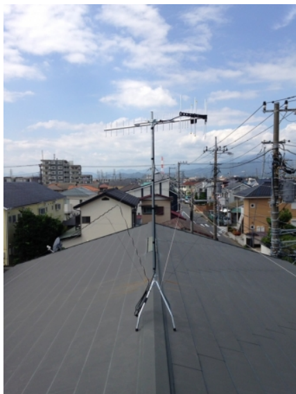
平塚市東真土 垂直偏波受信 地デジアンテナ屋根上工事
