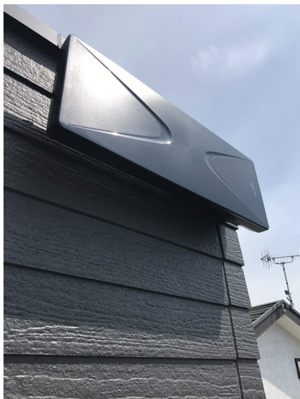
秦野市鶴巻南 GIエステート様ご物件 壁面取付 垂直デザインアンテナ工事
