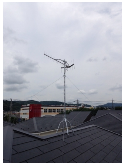
秦野市平沢 一建設様物件 垂直偏波受信 地デジアンテナ屋根上工事
