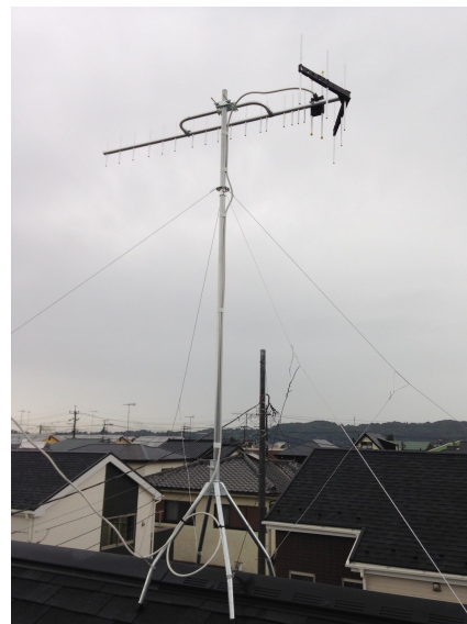
秦野市曽屋 地デジアンテナ屋根上工事
