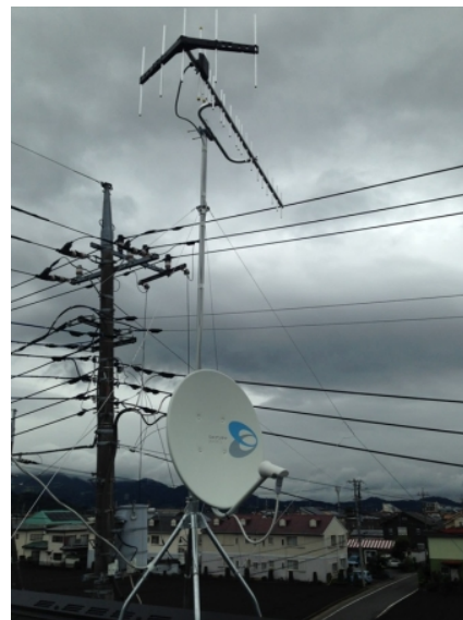
秦野市戸川 垂直偏波受信 地デジアンテナとBSアンテナ屋根上工事
