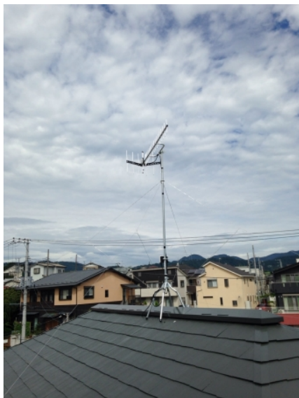
秦野市千村 垂直偏波受信 地デジアンテナ屋根上工事
