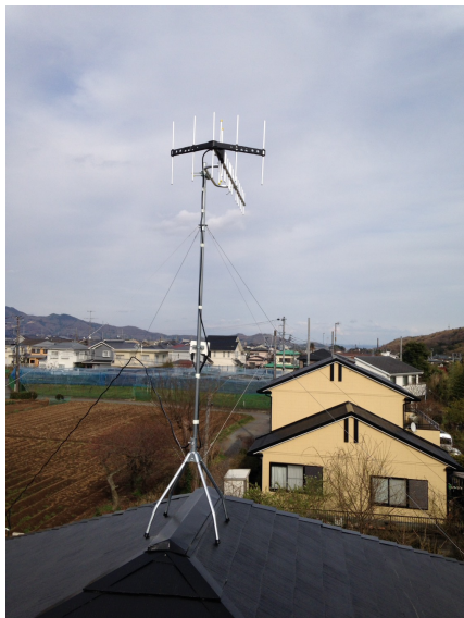
秦野市渋沢 屋根上設置 八木式アンテナ工事
