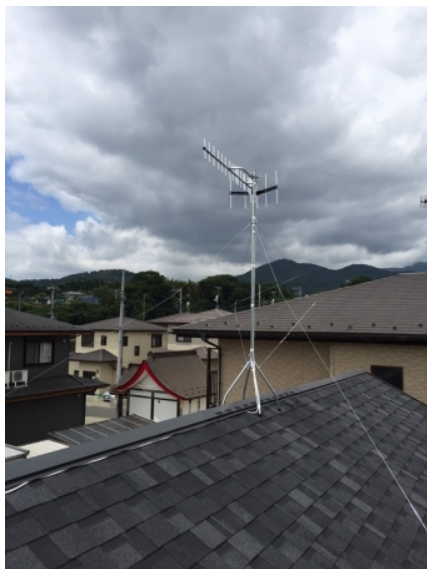
秦野市戸川 垂直偏波受信 地デジアンテナ屋根上工事
