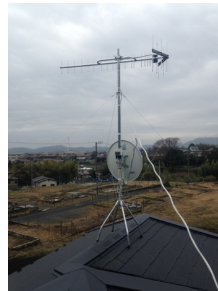
秦野市菩提 プライムランド様物件 地デジアンテナとBSアンテナ屋根上工事
