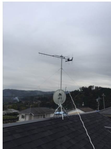
秦野市堀西 垂直偏波受信 地デジアンテナとBSアンテナ屋根上工事
