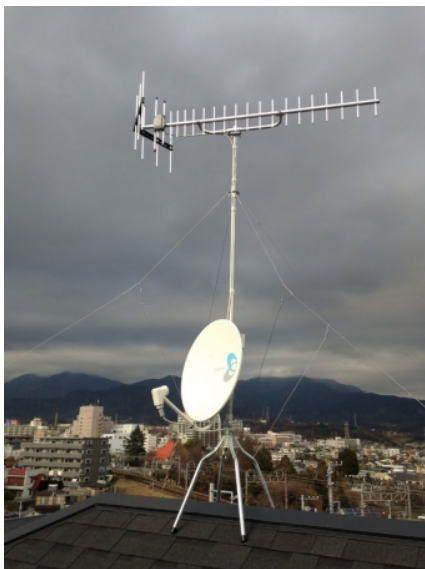
秦野市尾尻 垂直偏波受信 地デジアンテナとBSアンテナ屋根上工事
