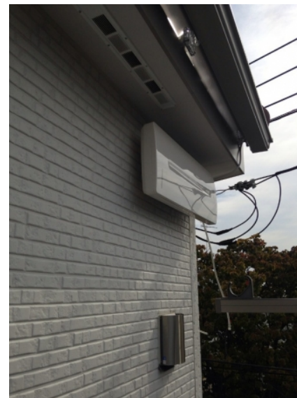
秦野市鶴巻 垂直偏波受信 壁面取付 デザインアンテナ工事
