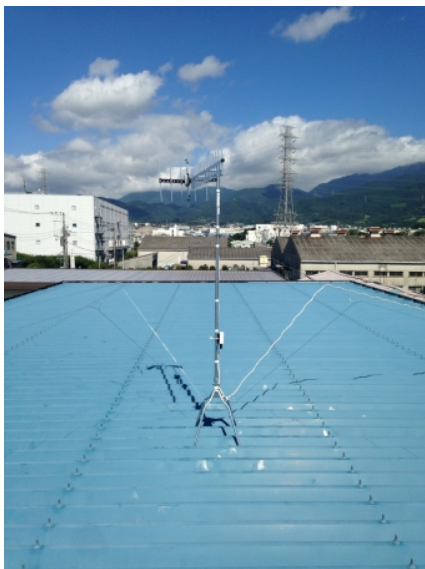
秦野市曽屋 垂直偏波受信 地デジアンテナ屋根上工事
