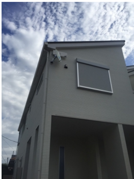
茅ヶ崎市赤羽根 垂直偏波受信 壁面取付 地デジアンテナ工事
