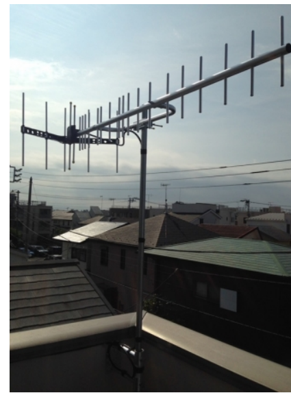
茅ヶ崎市東海岸北 垂直偏波受信 壁面取付 地デジアンテナ工事
