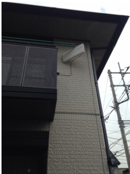
茅ヶ崎市南湖 垂直偏波受信 地デジアンテナ工事後の外観
