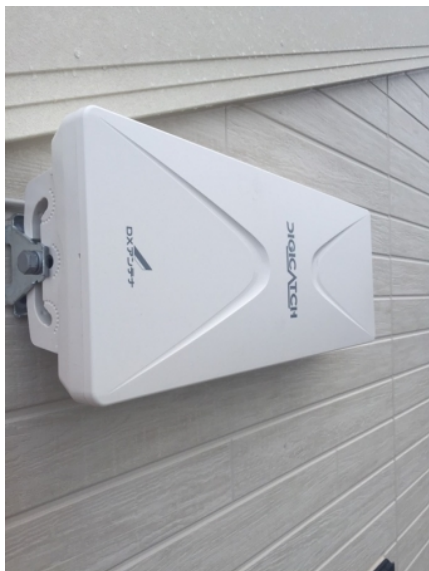
茅ヶ崎市萩園 片野建設様物件 垂直偏波受信 壁面取付 デザインアンテナ工事
