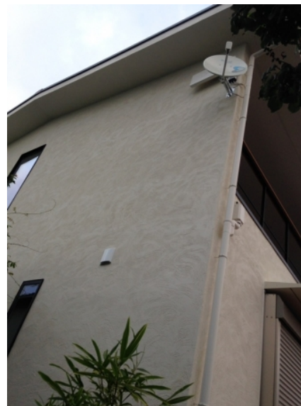
茅ヶ崎市柳島 ecomo様物件 垂直偏波受信 壁面取付 デザインアンテナとBSアンテナ工事
