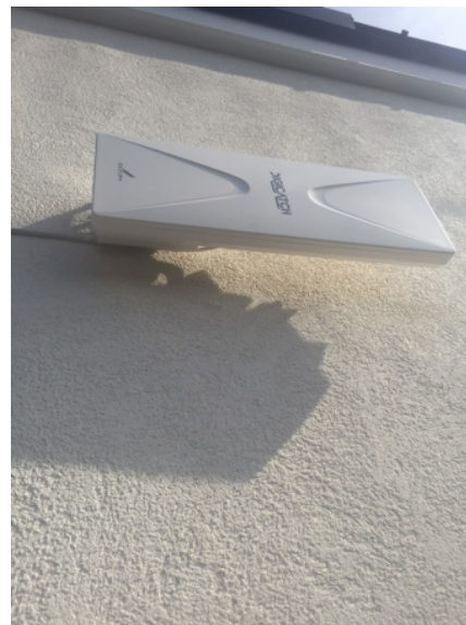
茅ヶ崎市旭が丘 ハートフル様物件 垂直偏波受信 壁面取付 デザインアンテナ工事
