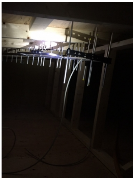
茅ヶ崎市今宿 一条工務店様物件 垂直偏波受信 地デジアンテナ屋根裏工事
