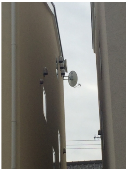
茅ヶ崎市松浪 八正建設様物件 垂直偏波受信 壁面取付 デザインアンテナとB Sアンテナ工事
