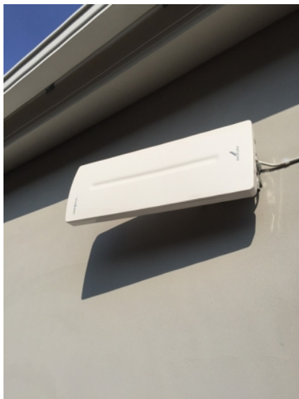
茅ヶ崎市辻堂 今出川建設様物件 垂直偏波受信 壁面取付 デザインアンテナ工事
