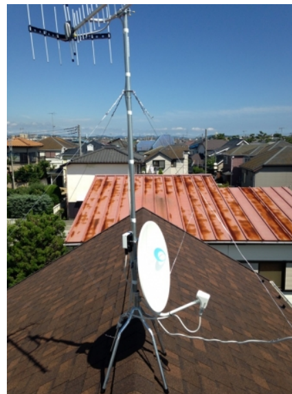
茅ヶ崎市美住町 垂直偏波受信 地デジアンテナとBSアンテナ屋根上工事
