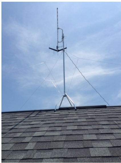
茅ヶ崎市東海岸 飯田産業様物件 垂直偏波受信 地デジアンテナ屋根上工事
