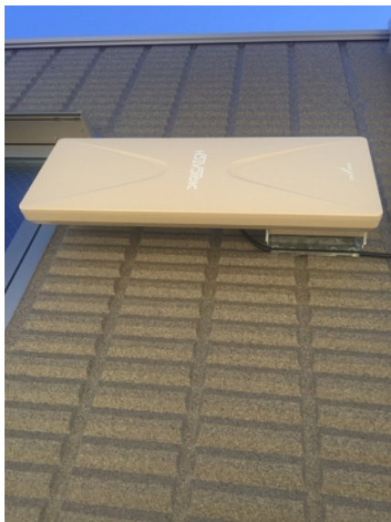
茅ヶ崎市松浪 旭化成様物件 垂直偏波受信 壁面取付 デザインアンテナ工事
