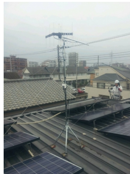
茅ヶ崎市高田 セキスイハウス様物件 地デジアンテナ屋根上工事
