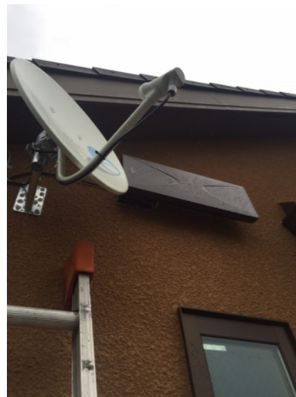
茅ヶ崎市菱沼 三井ホーム様物件 垂直偏波受信 壁面取付 デザインアンテナとB Sアンテナ工事
