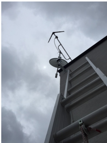
茅ヶ崎市東海岸南 垂直偏波受信 壁面取付 地デジアンテナとBSアンテナ工事
