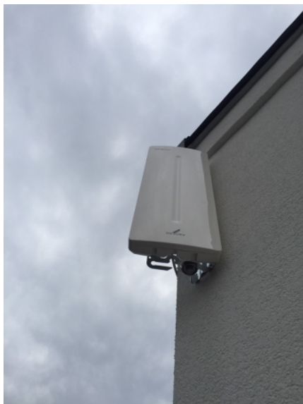
茅ヶ崎市松が丘 ハートフルホーム様物件 壁面取付 デザインアンテナ工事
