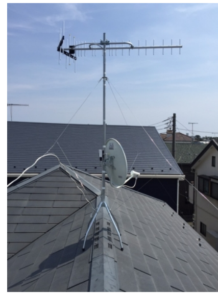
茅ヶ崎市共恵 一建設様物件 垂直偏波受信 地デジアンテナとBSアンテナ屋根上工事
