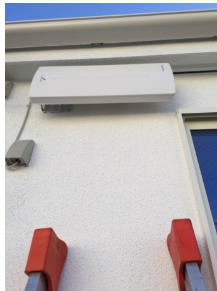
茅ヶ崎市松林 タツミプランニング様物件 垂直 偏波受信 壁面取付 デザインアンテナ工事
