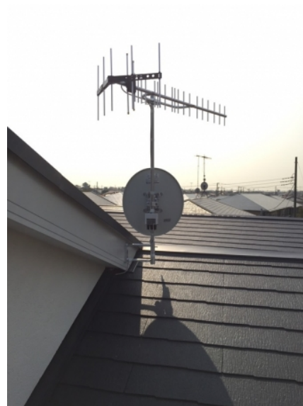
茅ヶ崎市浜竹 八正建設様物件 垂直偏波受信 壁面取付 地デジアンテナとBSアンテナ工事
