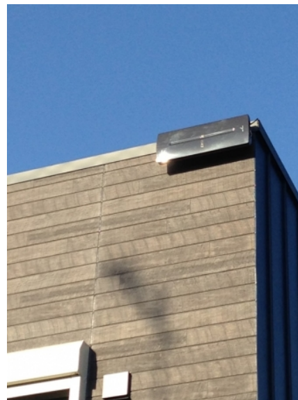
茅ヶ崎市南湖 ベツダイ様物件 垂直偏波受信 壁面取付 デザインアンテナ工事
