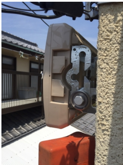
茅ヶ崎市東海岸 ホームプランニング様物件 垂直偏波受信 壁面取付 デザインアンテナ工事
