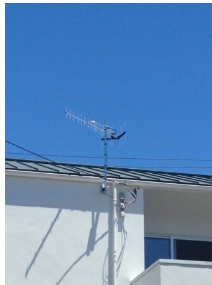
茅ヶ崎市浜須賀 エバークリーンホーム様物件 垂直偏波受信 壁面取付 地デジアンテナ工事
