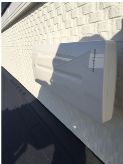
茅ヶ崎市出口町 ひかり建設様物件 垂直偏波受信 壁面取付 デザインアンテナ工事
