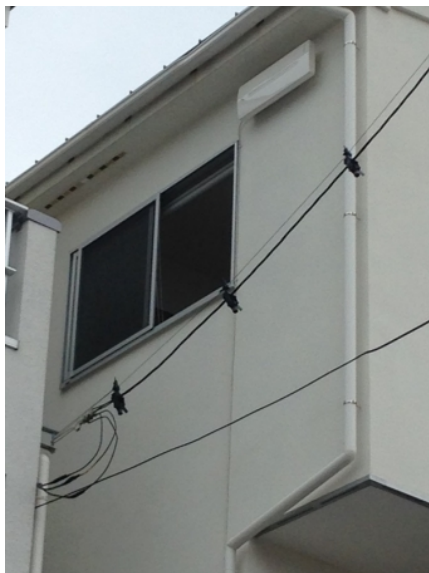
茅ヶ崎市美住町 ハートフルホーム様物件 垂直偏波受信 壁面取付 デザインアンテナ工事
