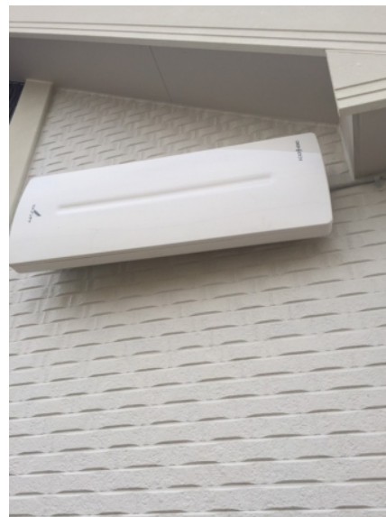
茅ヶ崎市室田 東栄住宅様物件 垂直偏波受信 壁面取付 デザインアンテナ工事
