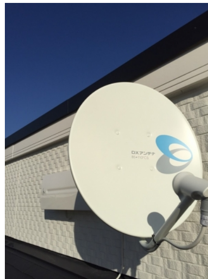
茅ヶ崎市出口町 ひかり建設様物件 垂直偏波受信 壁面取付 デザインアンテナとBSアンテナ工事
