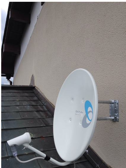
小田原市曽我別所 壁面取付 BSアンテナ工事
