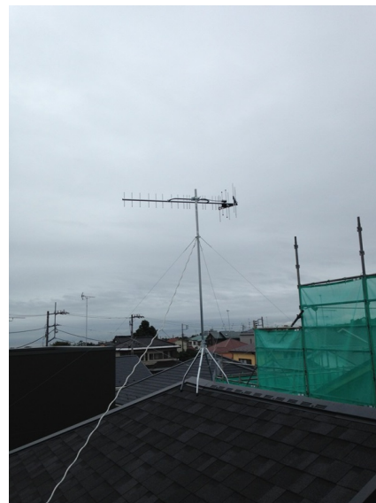
小田原市中村原 垂直偏波受信 地デジアンテナ屋根上工事
