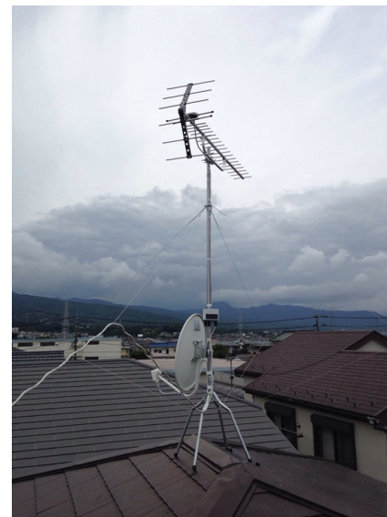
小田原市新屋 地デジアンテナとBSアンテナ屋根上工事
