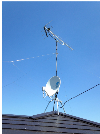
小田原市府川 地デジアンテナとBSアンテナ屋根上工事
