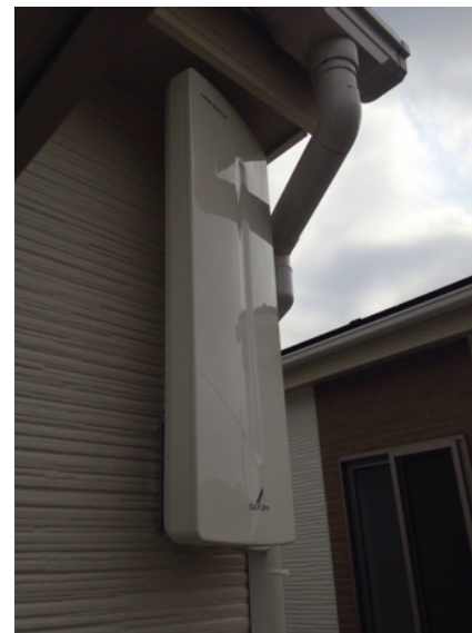
川崎市多摩区長澤 壁面取付 デザインアンテナ工事
