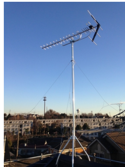
川崎市多摩区長沢 地デジアンテナ屋根上工事
