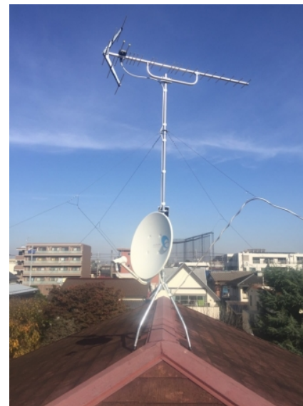
川崎市多摩区長尾 地デジアンテナとBSアンテナ屋根上工事
