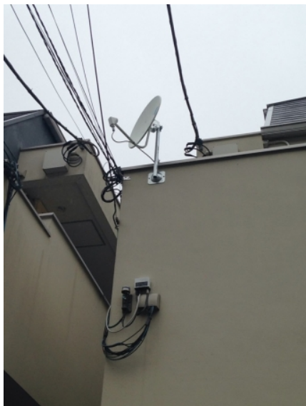
川崎市多摩区枳形 壁面取付 BSアンテナ工事
