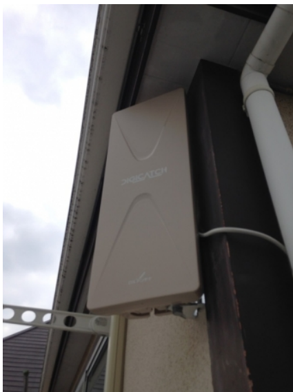
川崎市多摩区中野島 壁面取付 デザインアンテナ工事
