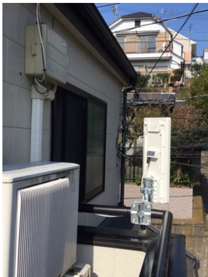
川崎市多摩区長沢 ベランダ取付 デザインアンテナ工事
