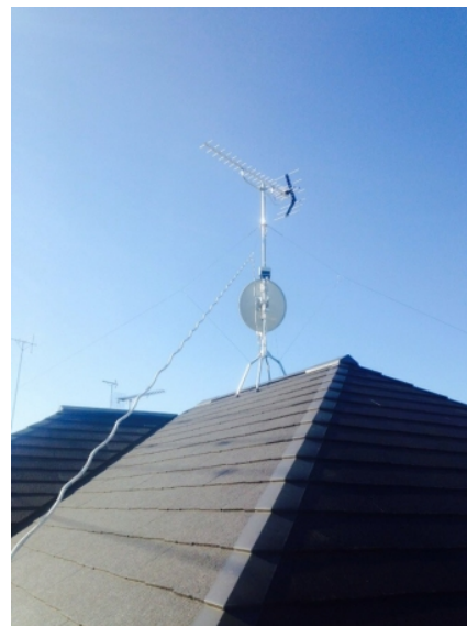
川崎市多摩区栗谷 地デジアンテナとBSアンテナ屋根上工事
