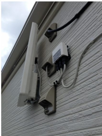
川崎市多摩区栗谷 壁面取付 デザインアンテナ工事
