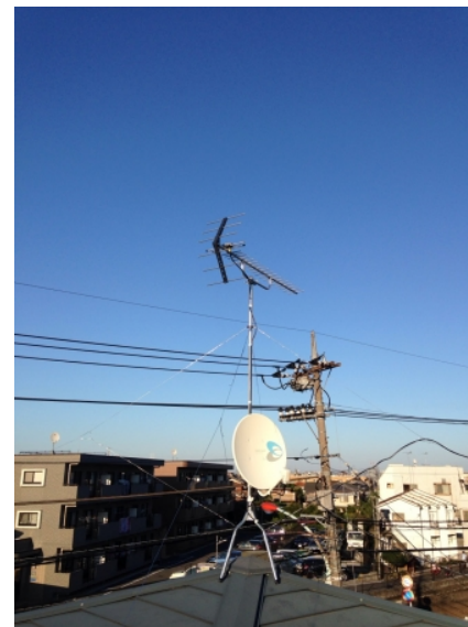
川崎市多摩区生田 地デジアンテナとBSアンテナ屋根上工事
