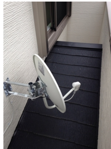
川崎市多摩区長沢 グローバルハウジング様物件 壁面取付 BSアンテナ工事
