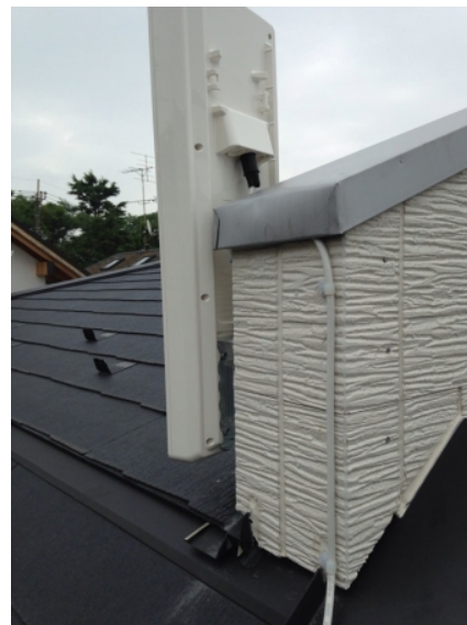
川崎市多摩区長沢 グローバルハウジング様物件 壁面取付 デザインアンテナ工事
