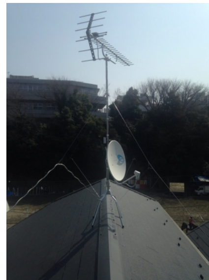
川崎市多摩区三用 アサヒハウジング様物件 地デジアンテナとBSアンテナ屋根上工事
