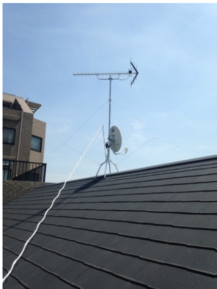
川崎市多摩区中野島 キャロットハウス・R様物件 地デジアンテナとBSアンテナ屋根上工事
