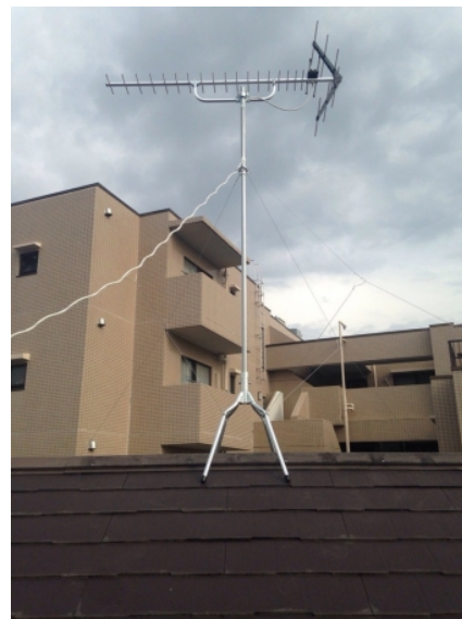
川崎市多摩区枳形 地デジアンテナ屋根上工事
