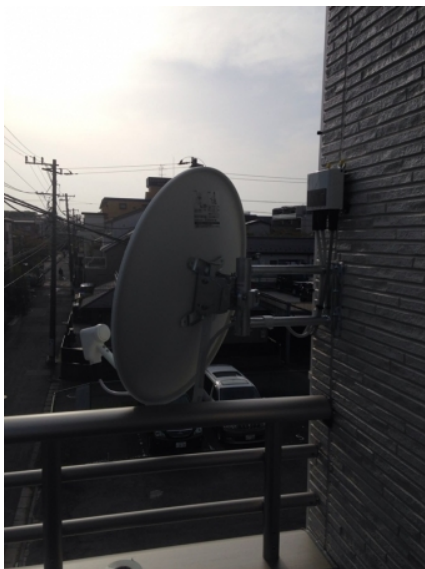
川崎市中原区今井南町 壁面取付 BSアンテナ工事
