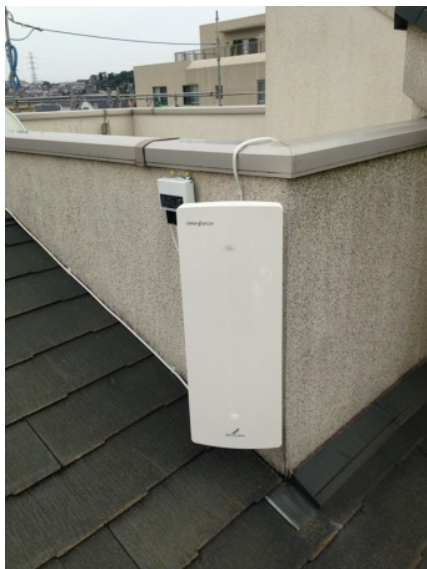
川崎市中原区井田杉山町 壁面取付 デザインアンテナ工事
