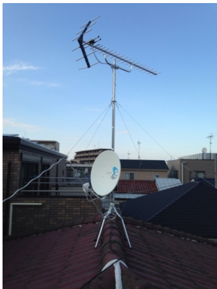
川崎市中原区北谷町 地デジアンテナとBSアンテナ屋根上工事
