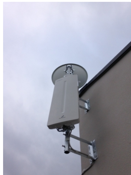
川崎市中原区小杉御殿町 イーホーム様物件 壁面取付 デザインアンテナとB Sアンテナ工事
