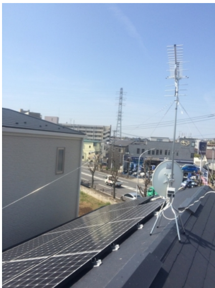
川崎市中原区下小田中 地デジアンテナとBSアンテナ屋根上工事
