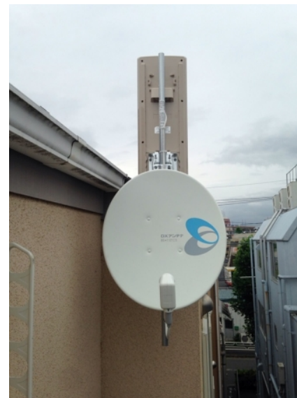
川崎市中原区上小田中 壁面取付 デザインアンテナとBSアンテナ工事
