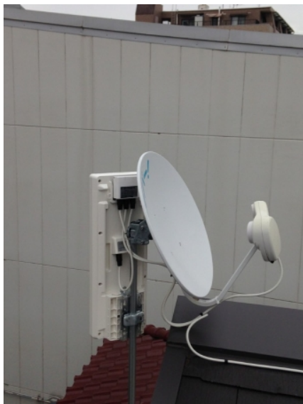
川崎市中原区宮内 ホームライフ様物件 壁面取付 デザインアンテナとB Sアンテナ工事
