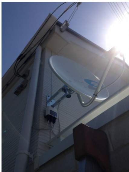
川崎市麻生区白鳥 壁面取付 BSアンテナ工事
