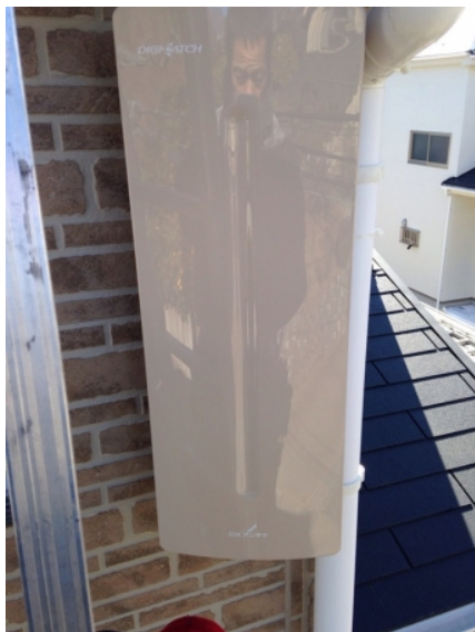
川崎市麻生区下麻生 壁面取付 デザインアンテナ工事
