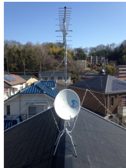
川崎市麻生区片平 地デジアンテナとBSアンテナ屋根上工事
