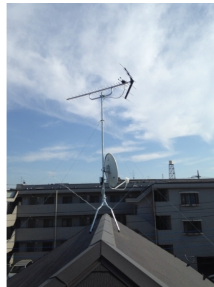
川崎市麻生区千代ヶ岡 タマック様物件 地デジアンテナとBSアンテナ屋根上工事
