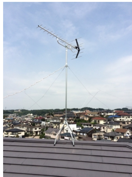
川崎市麻生区金程 地デジアンテナ屋根上工事
