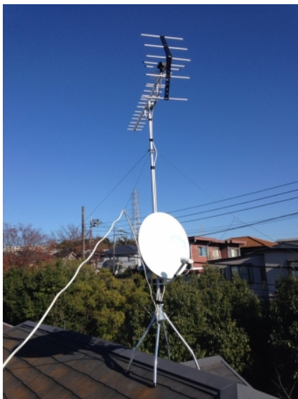
川崎市麻生区上麻生 地デジアンテナとBSアンテナ工事後の外観
