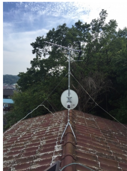
川崎市麻生区下麻生 地デジアンテナとBSアンテナ屋根上工事
