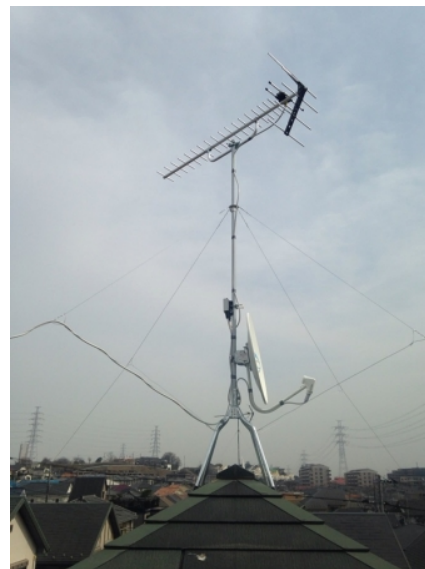
川崎市麻生区栗木台 セキスイハウス様物件 地デジアンテナとBSアンテナ屋根上工事
