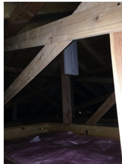
川崎市麻生区王禅寺東 デザインアンテナ屋根裏工事
