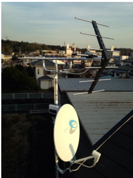
川崎市麻生区下麻生 壁面取付 地デジアンテナとBSアンテナ工事
