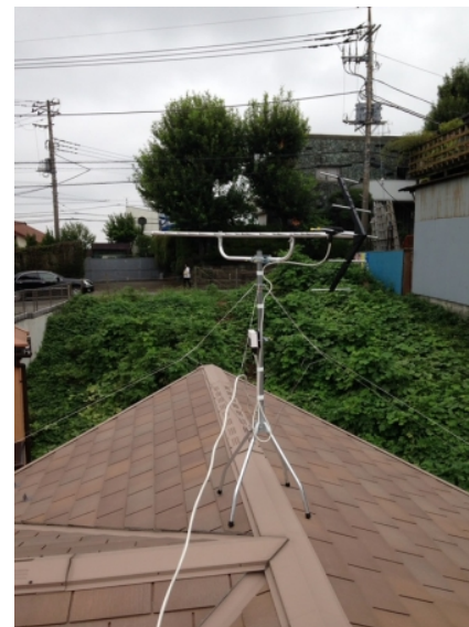
川崎市麻生区高石 三栄建築設計様物件 地デジアンテナ屋根上工事
