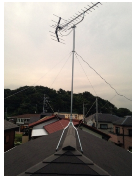
川崎市麻生区下麻生 地デジアンテナ屋根上工事
