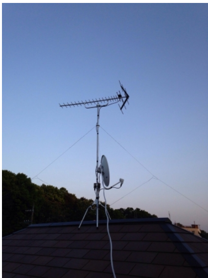
川崎市麻生区王禅寺西 地デジアンテナとBSアンテナ屋根上工事
