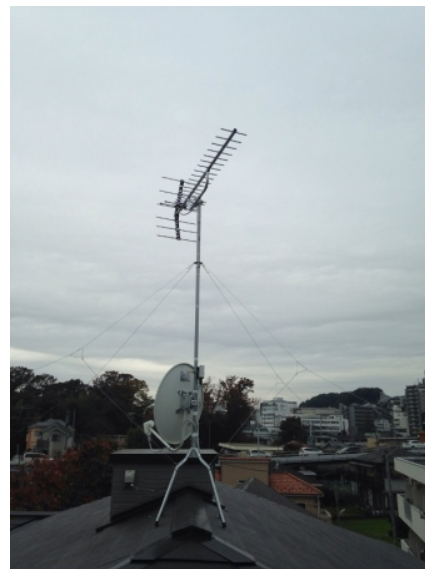
川崎市麻生区岡上 地デジアンテナとBSアンテナ屋根上工事
