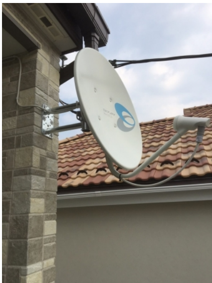
川崎市麻生区王禅寺 住宅情報館様物件 壁面取付 BSアンテナ工事
