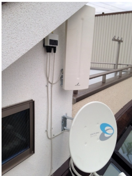
川崎市麻生区五力田 壁面取付 デザインアンテナとBSアンテナ工事
