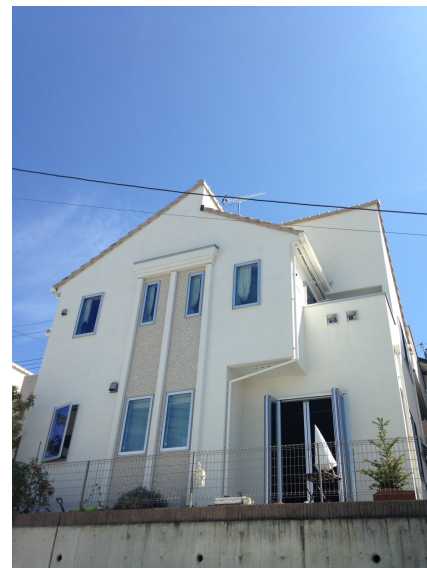
川崎市麻生区白鳥 地デジアンテナ工事後の外観
