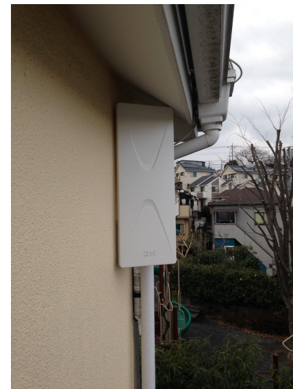
川崎市麻生区東百合丘 壁面取付 デザインアンテナ工事
