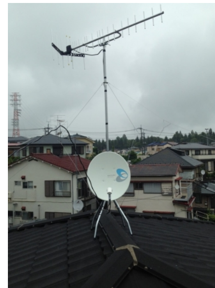
伊勢原市石田 積水ハウス様物件 垂直偏波受信 地デジアンテナとBSアンテナ屋根上工事
