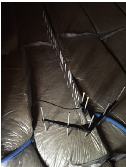
伊勢原市下糟屋 三菱地所様物件 垂直偏波受信 地デジアンテナ屋根裏工事
