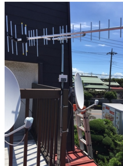
海老名市門沢橋 垂直偏波受信 地デジアンテナ工事
