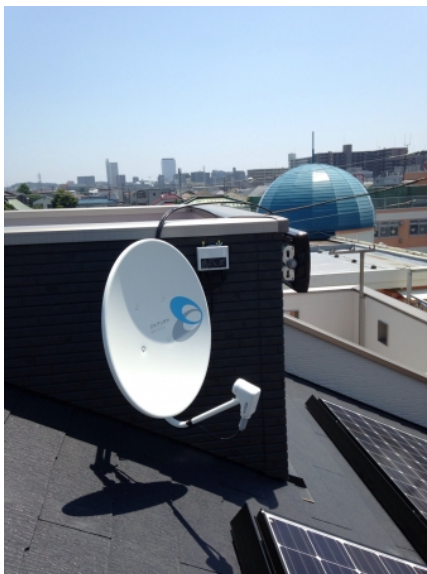
海老名市河原口 壁面取付 BSアンテナ工事
