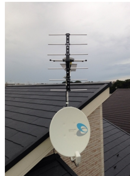
海老名市上今泉 壁面取付 地デジアンテナとBSアンテナ工事
