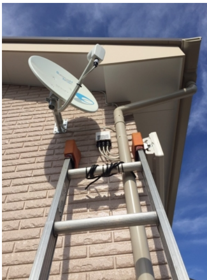
海老名市柏ヶ谷 垂直偏波受信 壁面取付 デザインアンテナとBSアンテナ工事
