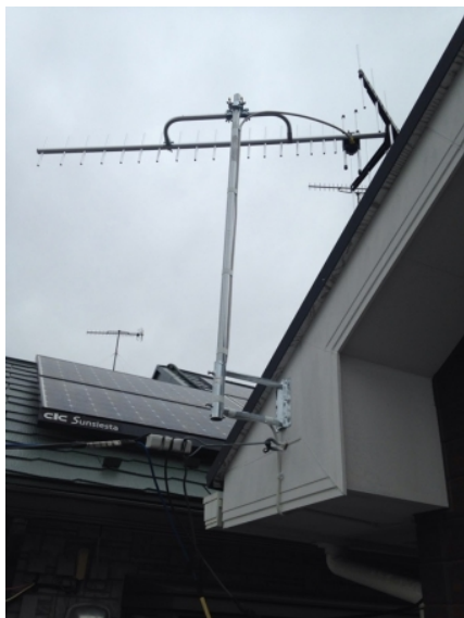
海老名市下今泉 垂直偏波受信 壁面取付 地デジアンテナ工事
