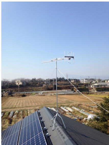
海老名市杉久保南 垂直偏波受信 地デジアンテナ屋根上工事
