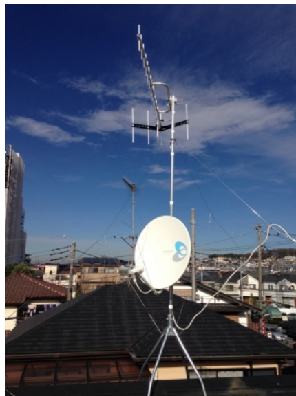
海老名市東柏ヶ谷 地デジアンテナ屋根上工事
