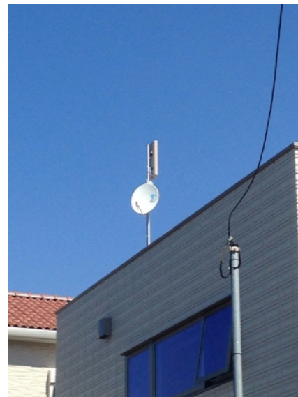
海老名市今里 デザインアンテナとBSアンテナ 工事
