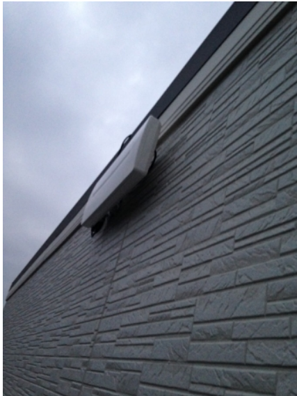
海老名市中新田 城南建設様物件 垂直偏波受信 壁面取付 デザインアンテナ工事
