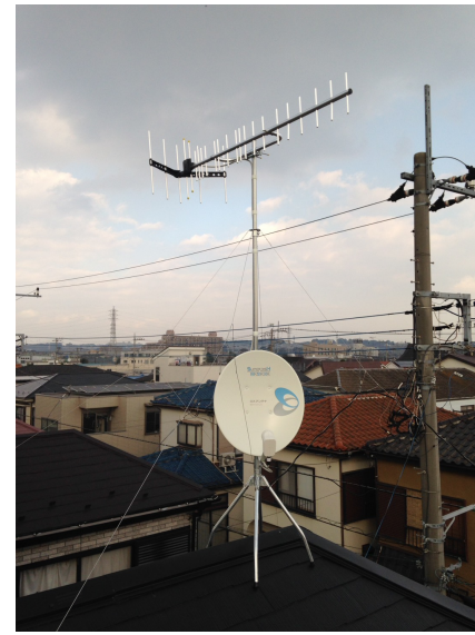
海老名市上郷 相鉄不動産様物件 地デジアンテナとBSアンテナ屋根上工事
