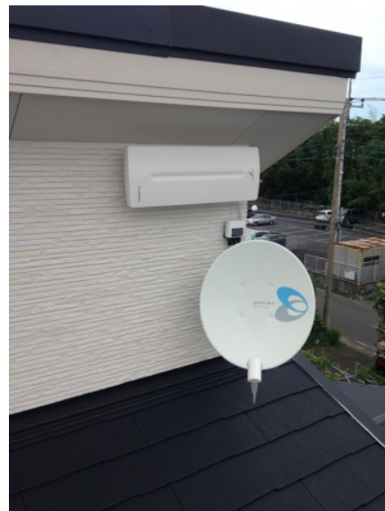
海老名市大谷北 住友不動産様物件 垂直偏波受信 壁面取付 デザインアンテナとBSアンテナ工事
