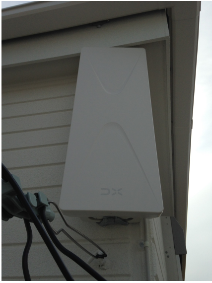
海老名市東柏ヶ谷 タクトホーム様ご物件 壁面取付 デザインアンテナ工事
