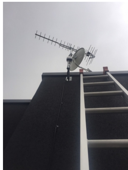
海老名市柏ヶ谷 和工務店様物件 壁面取付 地デジアンテナとBSアンテナ工事
