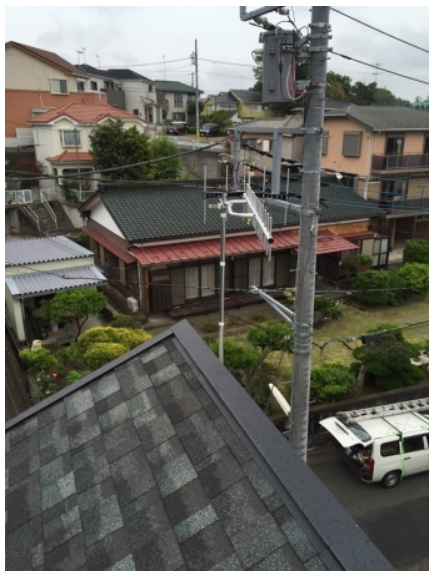
海老名市杉久保南 サンケイホーム様物件 垂直偏波受信 壁面取付 地デジアンテナ工事
