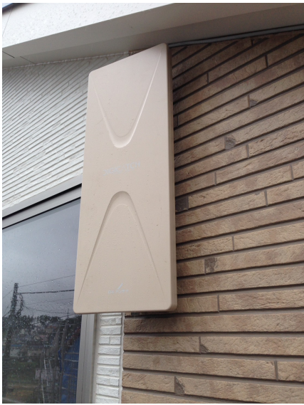
海老名市国分北 飯田産業様物件 壁面取付 デザインアンテナ工事
