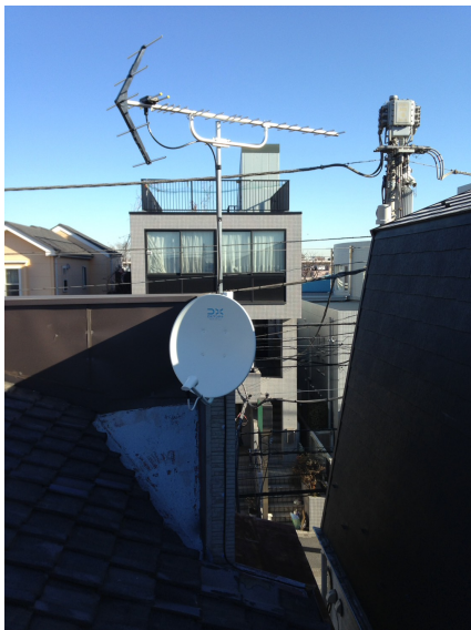
武蔵野市中町 壁面取付 八木式アンテナとBS/CSアンテナ工事
