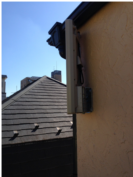
武蔵野市西久保 壁面取付 デザインアンテナ工事
