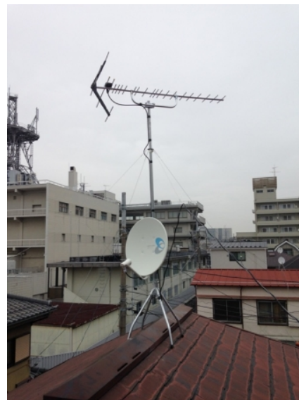
武蔵野市西久保 地デジアンテナとBSアンテナ屋根上工事
