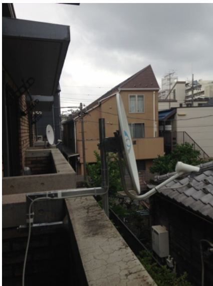
武蔵野市境南町 壁面取付 デザインアンテナ工事
