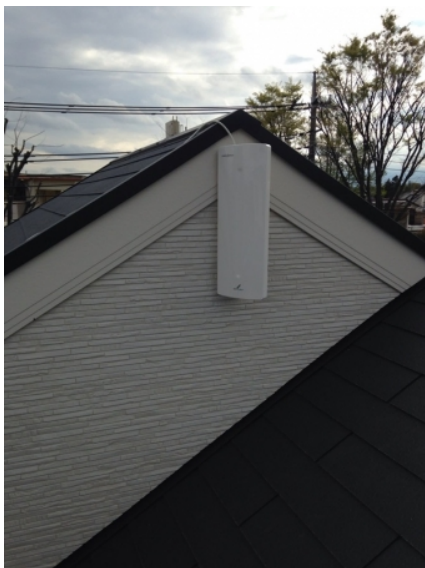
武蔵野市関前 アサカワホーム様物件 壁面取付 デザインアンテナ工事
