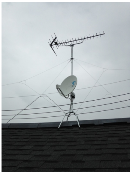
武蔵野市吉祥寺 地デジアンテナとBSアンテナ屋根上工事
