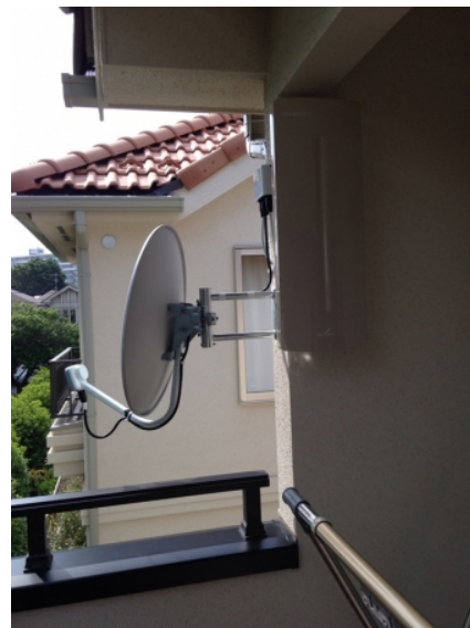
武蔵野市関前 西武建設様物件 壁面取付 デザインアンテナとBSアンテナ工事
