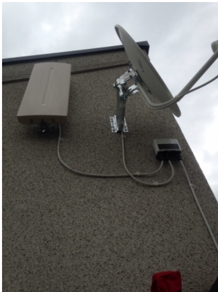
港区白金 壁面取付 デザインアンテナとBSアンテナ工事
