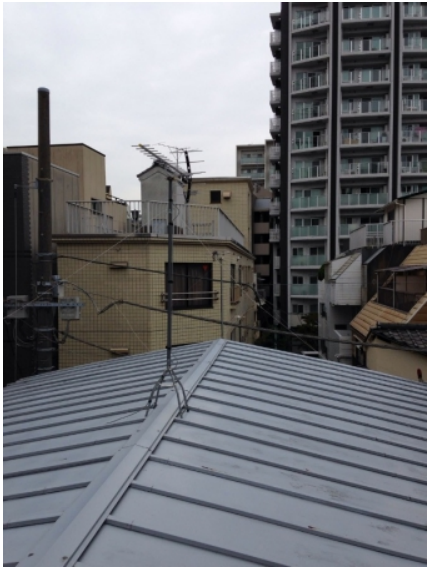
港区東麻布 地デジアンテナ追加工事
