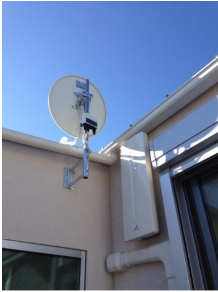
港区三田 壁面取付 デザインアンテナ工事
