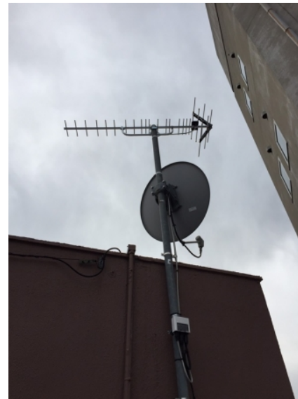
港区西麻布 地デジアンテナ交換工事
