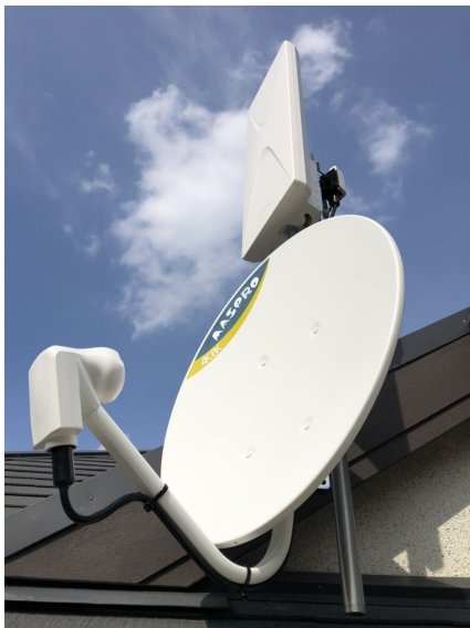
目黒区下目黒 デザインアンテナとBS/CSアンテナの破風設置
