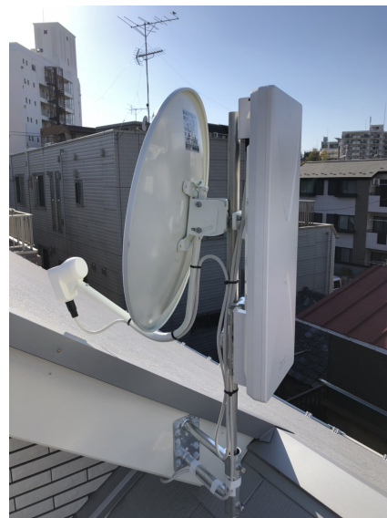
目黒区中根 一条工務店物件 デザインアンテナとBS/CSアンテナの破風設置
