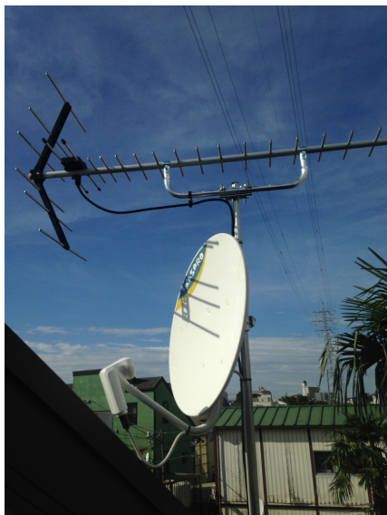
目黒区柿の木坂 ライブリーハウス物件 八木式アンテナとBS/CSアンテナの破風設置
