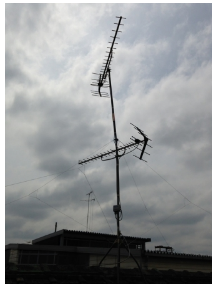
府中市日進町 地デジアンテナ屋根上工事
