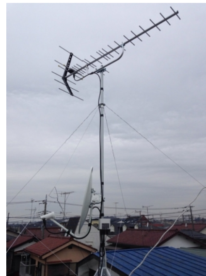
府中市紅葉丘 地デジアンテナとBSアンテナ屋根上工事
