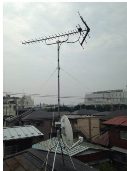
府中市四谷 地デジアンテナとBSアンテナ屋根上工事
