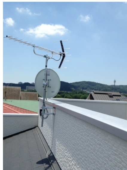
府中市小柳町 壁面取付 地デジアンテナとBSアンテナ工事
