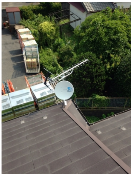
府中市四谷 壁面取付 地デジアンテナとBSアンテナ工事
