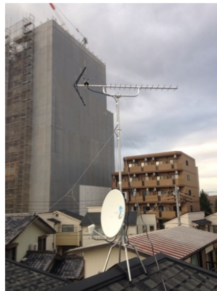
府中市白糸台 地デジアンテナとBSアンテナ屋根上工事
