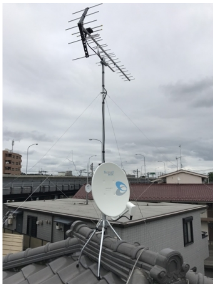
府中市本町 地デジアンテナとB S アンテナ屋根 上工事
