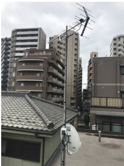
府中市八幡町 地デジアンテナとBSアンテナ取 付工事
