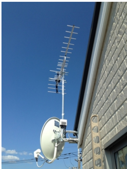
府中市八幡 壁面取付 地デジアンテナとBSアンテナ工事
