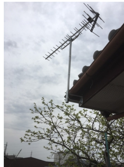
府中市日新町 壁面取付 地デジアンテナ工事
