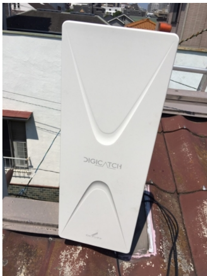
府中市八幡町 松尾住宅サービス様物件 壁面取付 デザインアンテナ工事
