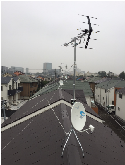
府中市本宿町 オープンハウスアーキテクト様物件 地デジアンテナとBSアンテナ屋根上工事
