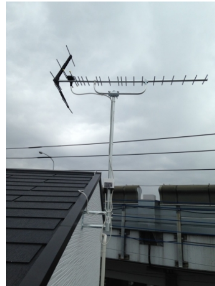
府中市矢崎 ホークワン様物件 壁面取付 地デジアンテナ工事
