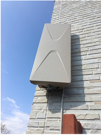
府中市四谷 住宅情報館様ご物件 壁面取付 デザインアンテナ工事
