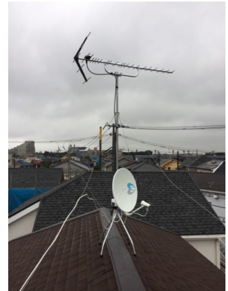
府中市本町 飯田産業様物件 地デジアンテナとBSアンテナ屋根上工事
