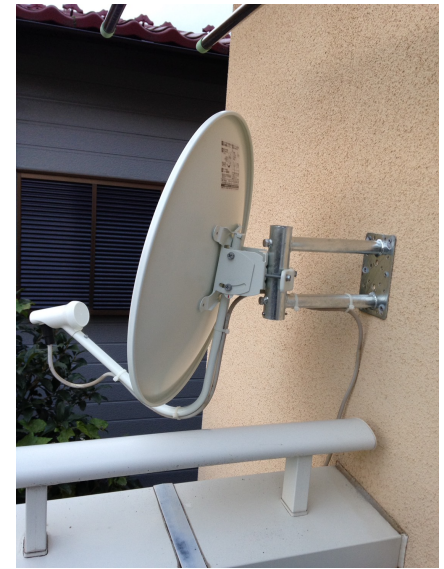
府中市寿町 壁面取付 BSアンテナ工事
