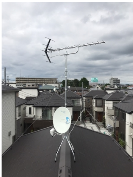
府中市若松町 アグレ都市デザイン様物件 地デジアンテナとBSアンテナ屋根上工事
