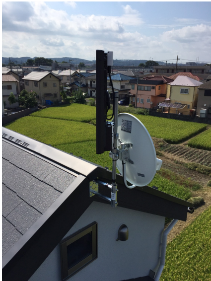
府中市分梅町 ノーヴァアソシエイツ様物件 デザインアンテナとBSアンテナ工事
