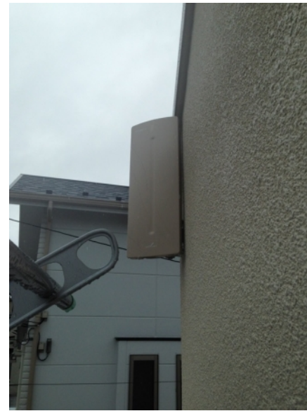
三鷹市牟礼 壁面取付 デザインアンテナ工事
