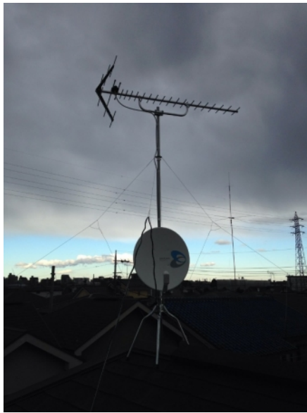
三鷹市上連雀 地デジアンテナとBSアンテナ屋根上工事
