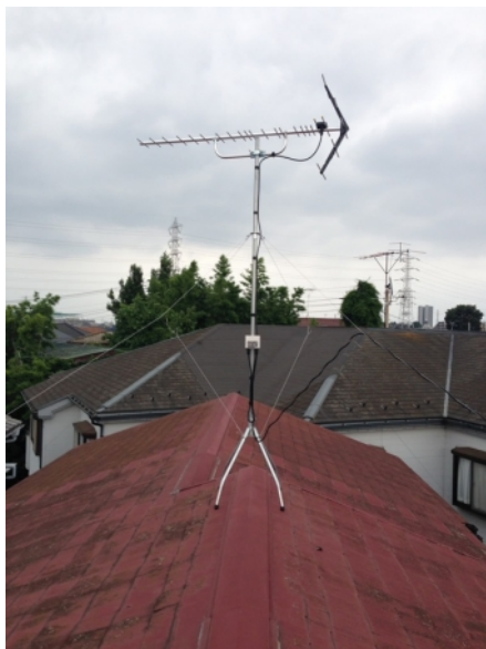
三鷹市牟礼 地デジアンテナ屋根上工事
