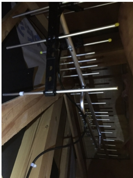
三鷹市深大寺 地デジアンテナ屋根裏工事
