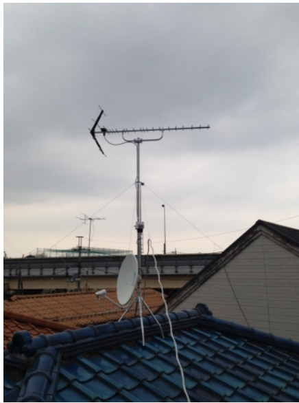
三鷹市北野 地デジアンテナとBSアンテナ屋根上工事
