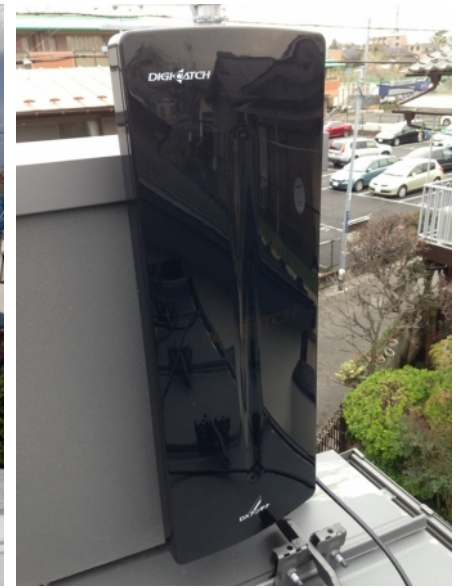
三鷹市牟礼 壁面取付 デザインアンテナ工事
