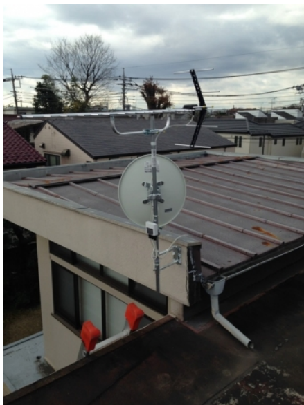
三鷹市井の頭 壁面取付 BSアンテナ追加工事
