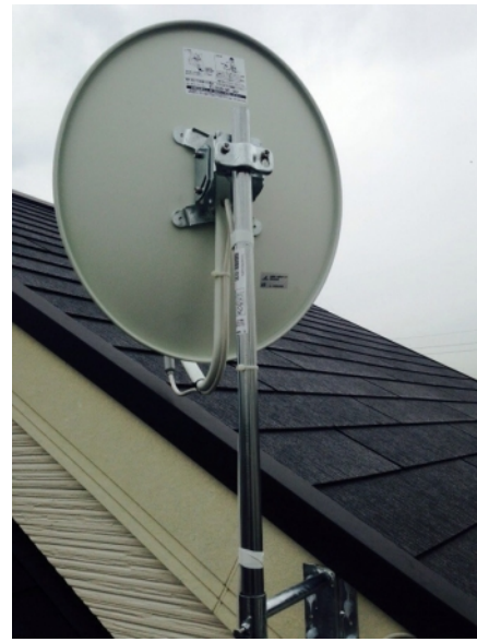
三鷹市中原 壁面取付 BSアンテナ工事
