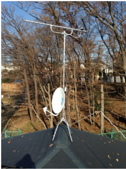
三鷹市中原 地デジアンテナとBSアンテナ屋根上工事
