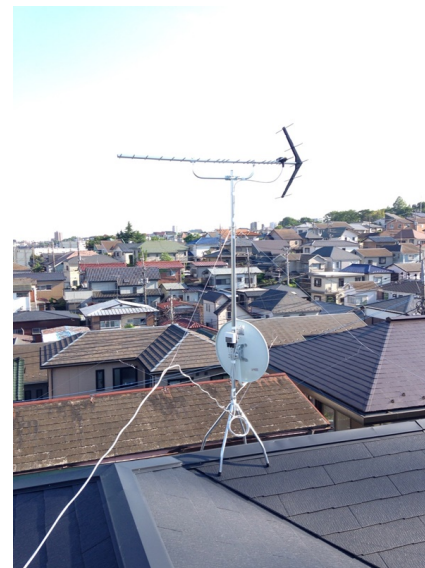
町田市南大谷 地デジアンテナとBSアンテナ屋根上工事
