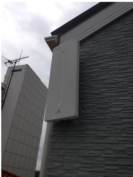
町田市中町 壁面取付 デザインアンテナ工事
