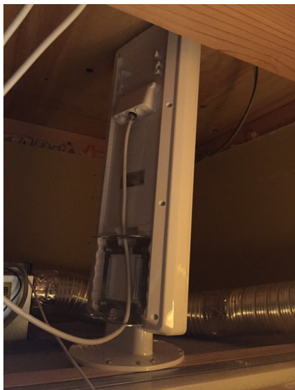
町田市野津田 デザインアンテナ屋根裏工事
