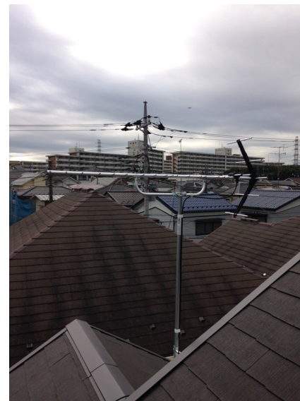
町田市木曽東 壁面取付 地デジアンテナ工事
