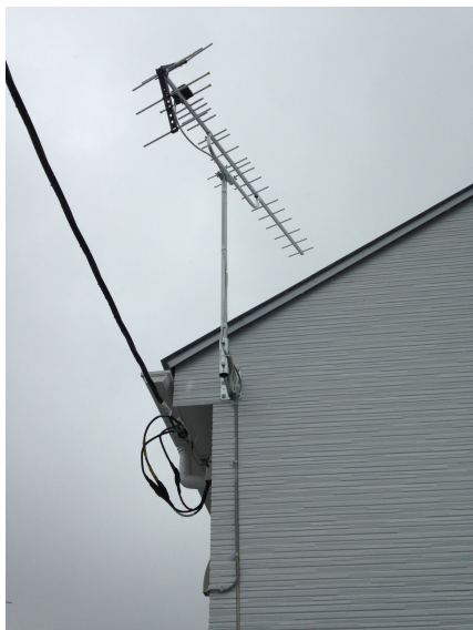
町田市鶴間 壁面設置 地デジアンテナ工事
