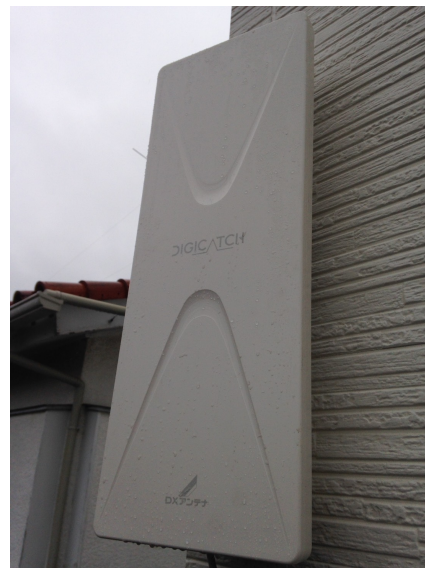
町田市金森東 壁面取付 デザインアンテナ工事
