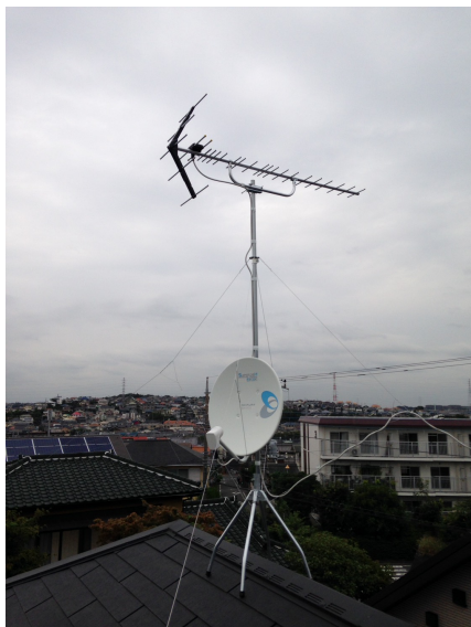
町田市南成瀬 地デジアンテナとBSアンテナ屋根上工事
