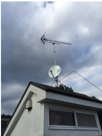
日野市旭が丘 地デジアンテナとBSアンテナ屋根上工事
