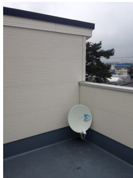
日野市栄町 壁面取付 BSアンテナ工事
