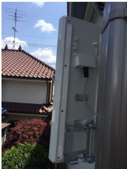
日野市豊田 壁面取付 デザインアンテナ工事
