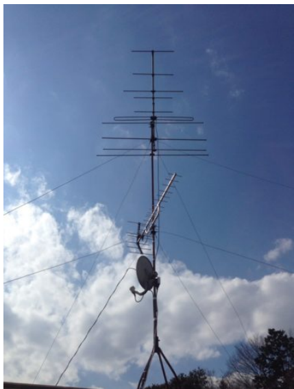
日野市日野 地デジアンテナ追加工事
