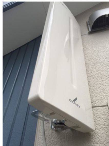
日野市東平山 壁面取付 デザインアンテナ工事
