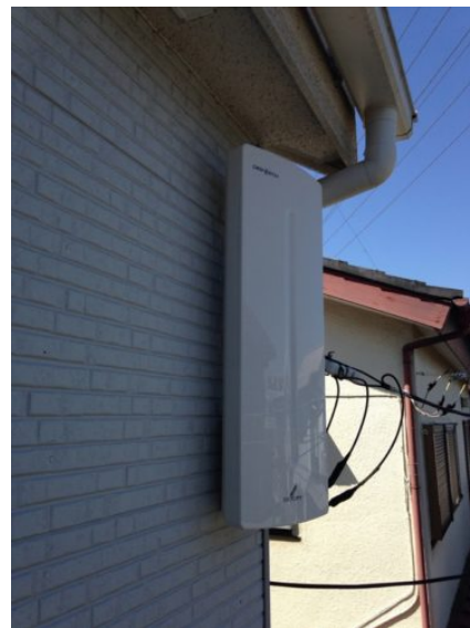
日野市旭が丘 壁面取付 デザインアンテナ工事
