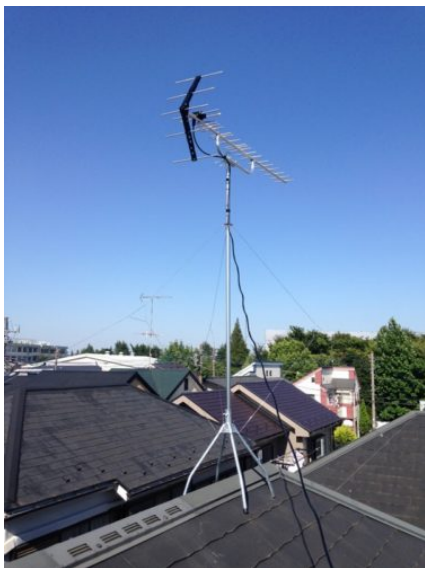
日野市大坂上 地デジアンテナ屋根上工事
