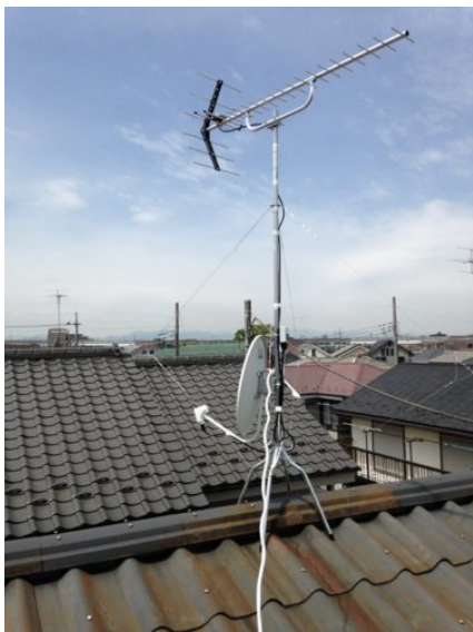
日野市高幡 地デジアンテナとBSアンテナ屋根上工事
