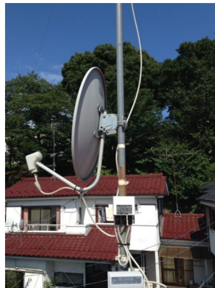
日野市多摩平 ダイワハウス様物件 ブースター交換・分配器交換
