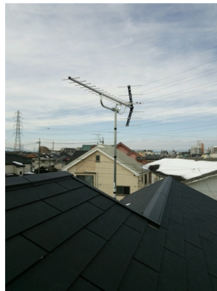
東大和市中心 壁面取付 地デジアンテナ工事
