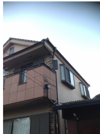
東大和市奈良橋
