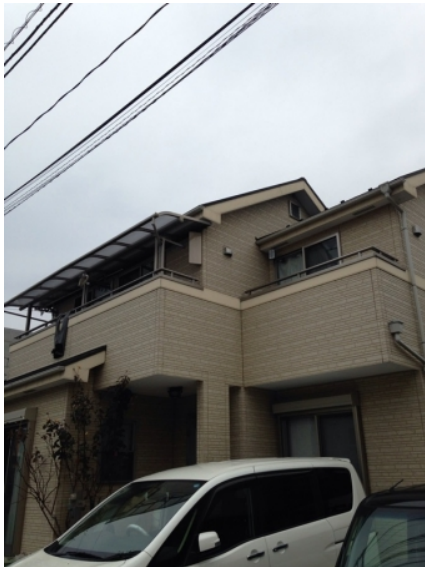
東大和市仲原 デザインアンテナ工事後の外観
