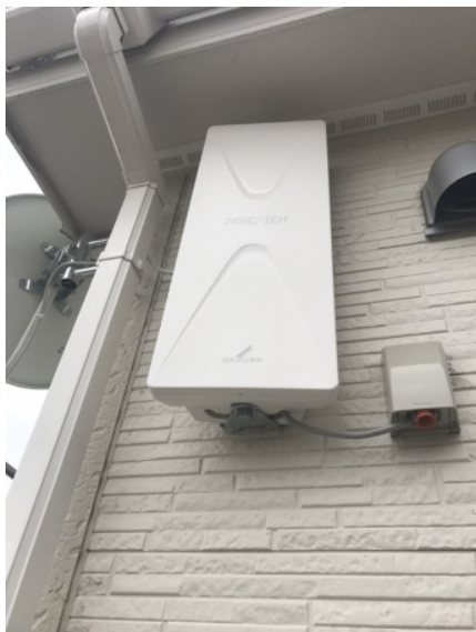
東大和市奈良橋 壁面取付 デザインアンテナ工事
