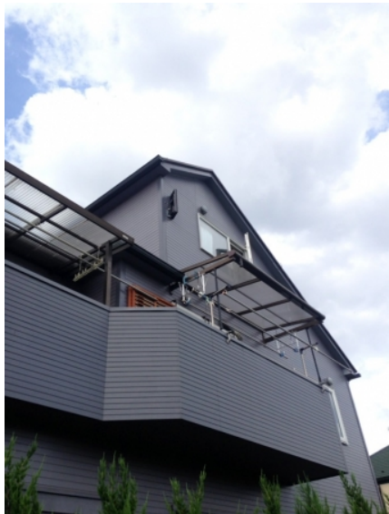
東大和市清水 デザインアンテナ工事後の外観
