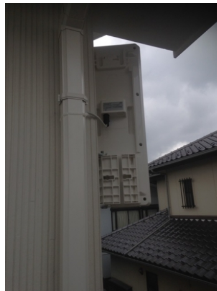
東大和市清水 地デジアンテナ屋根上工事
