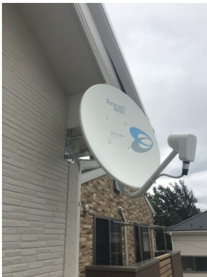
東大和市奈良橋 壁面取付 BSアンテナ工事
