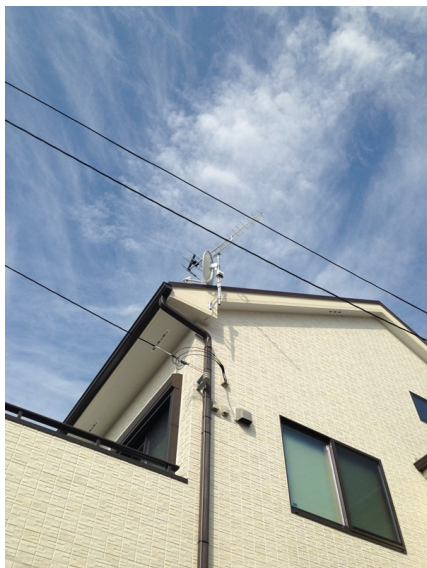
八王子市子安町 清水木材様物権 地デジアンテナとBSアンテナ工事後の外観
