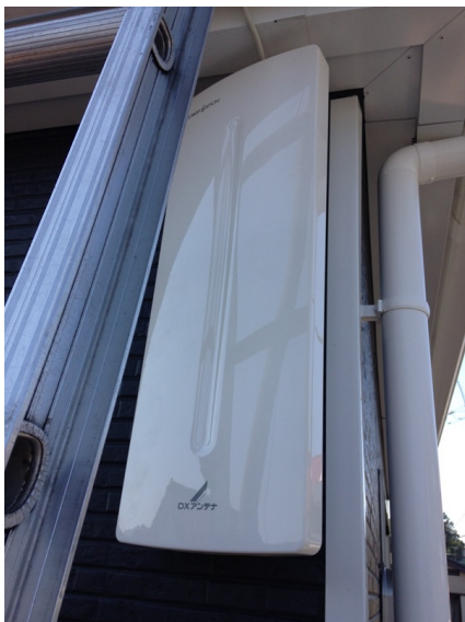
八王子市子安町 清水木材様物件 地デジアンテナとBSアンテナ工事後の外観
