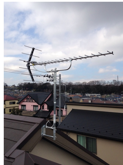
八王子市片倉町 小田急不動産様物件 壁面取付 地デジアンテナ工事
