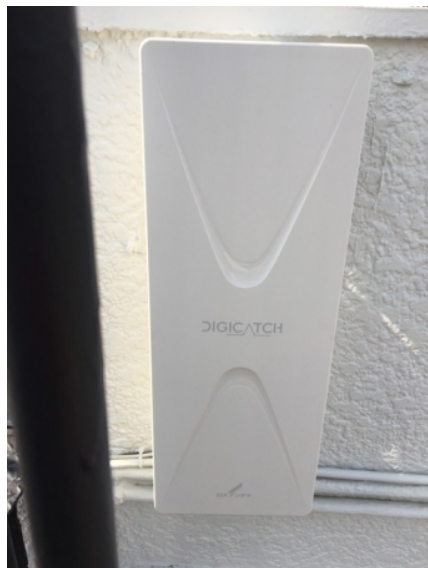
文京区白山 壁面取付 デザインアンテナ工事
