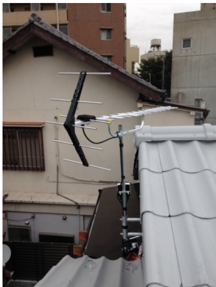
文京区本駒込 壁面取付 地デジアンテナ工事
