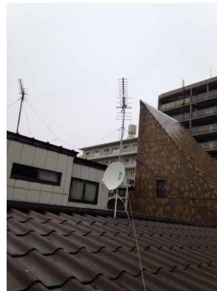
文京区白山 地デジアンテナとBSアンテナ屋根上工事
