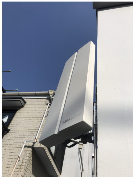
文京区白山 無印良品様ご物件 壁面取付 デザインアンテナ工事
