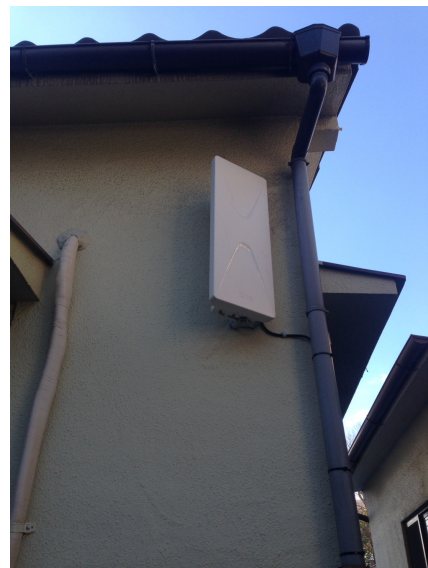
文京区春日 イーダブルジー様ご物件 壁面取付 デザインアンテナ工事
