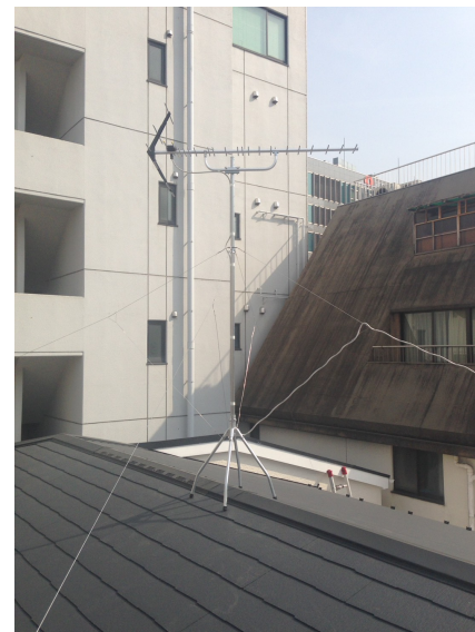
文京区湯島 屋根上設置 八木式アンテナ工事
