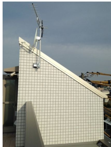
文京区白山 パナホーム様物件 壁面取付 地デジアンテナとBSアンテナ工事
