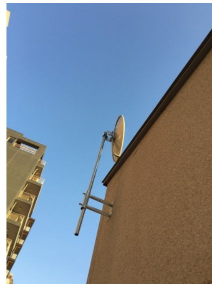
文京区春日 壁面取付 B S アンテナ工事
