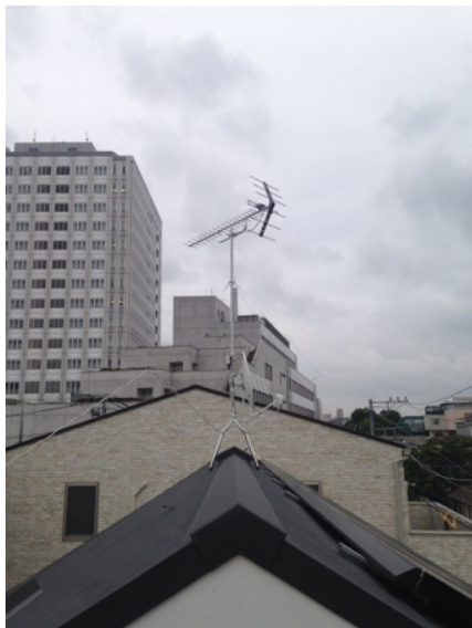
文京区白山 三井ホーム様物件 地デジアンテナとBSアンテナ屋根上工事
