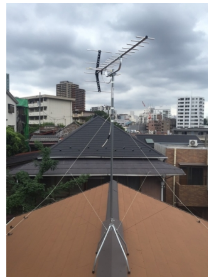
文京区本郷 東急ホームズ様物件 地デジアンテナ屋根上工事
