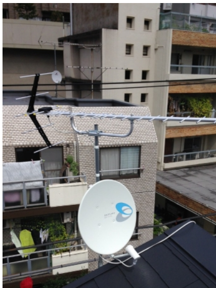
文京区千石 三栄建築設計様物件 壁面取付 地デジアンテナとBSアンテナ工事
