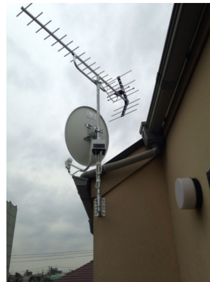
豊島区高松 壁面取付 地デジアンテナとBSアンテナ工事
