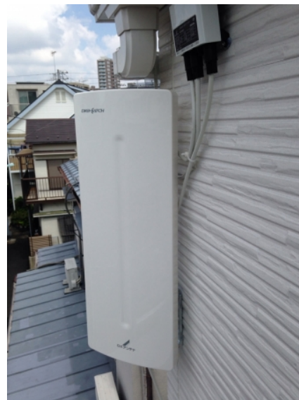
豊島区千早 壁面取付 デザインアンテナ工事
