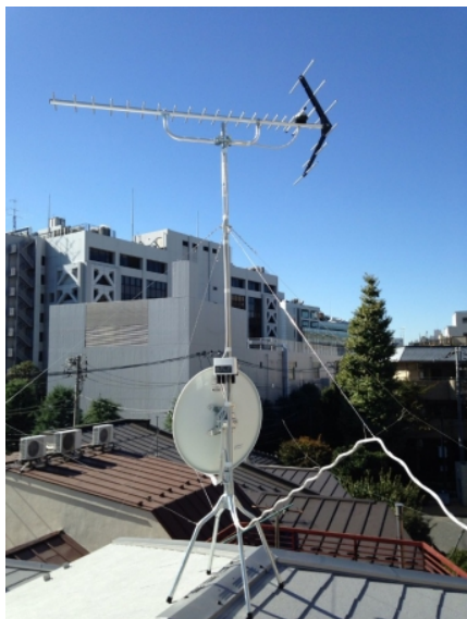
豊島区高田 地デジアンテナとBSアンテナ屋根上工事
