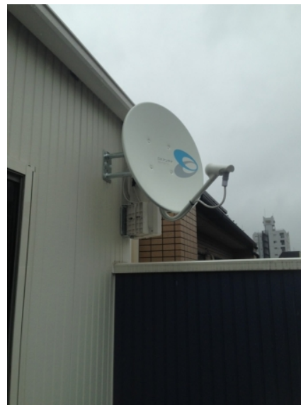
豊島区上池袋 壁面取付 デザインアンテナとBSアンテナ工事
