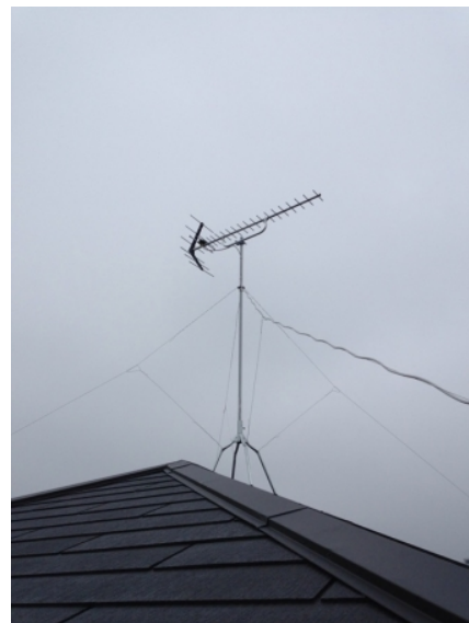
豊島区巣鴨 地デジアンテナ屋根上工事
