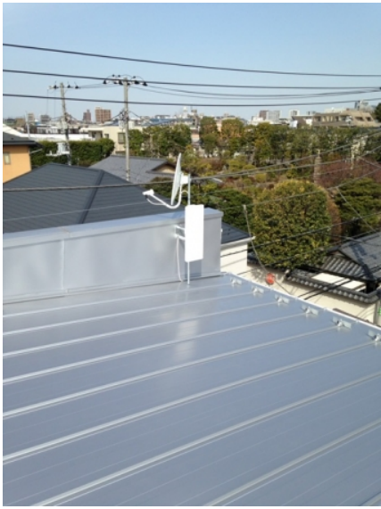
豊島区目白 デザインアンテナとBSアンテナ屋根上工事
