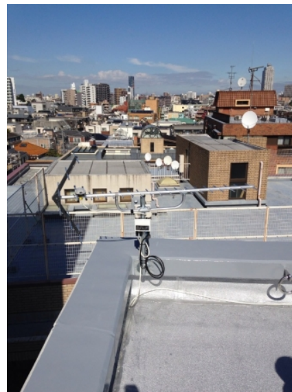
豊島区目白 ビル工事 地デジアンテナ
