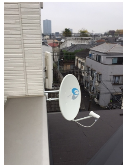
豊島区目白 オープンハウス様物件 壁面取付 デザインアンテナとBSアンテナ工事
