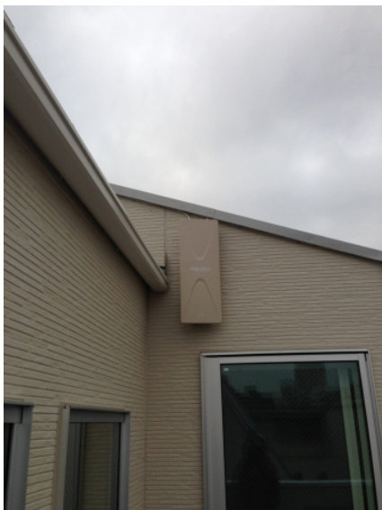
豊島区高松 三栄建築様物件 壁面取付 デザインアンテナ工事
