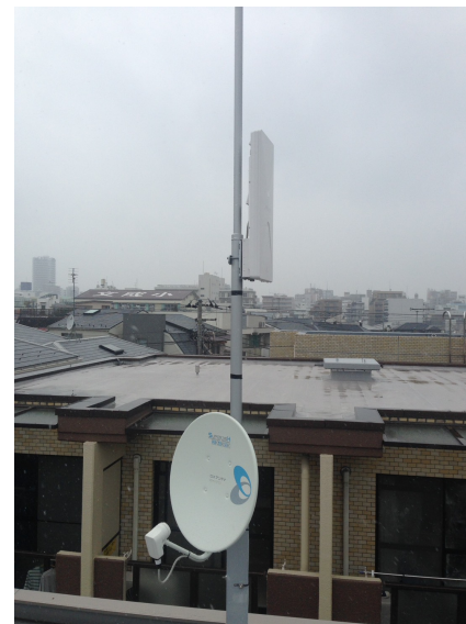
豊島区池袋本町 ポール設置 デザインアンテナとBSアンテナ工事
