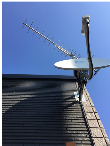
豊島区池袋 壁面取付 八木式アンテナとBS/CSアンテナ工事
