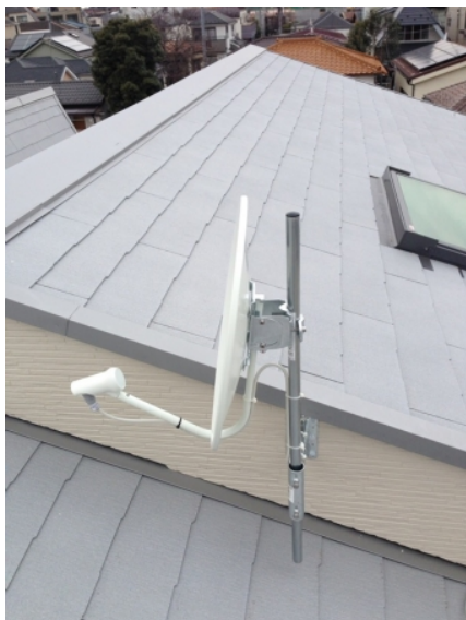
豊島区高松 三栄建築様物件 壁面取付 BSアンテナ工事
