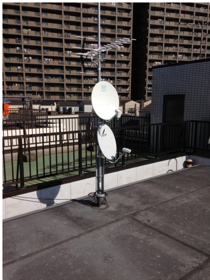
豊島区池袋本町 八木式アンテナとBS/CSアンテナ工事
