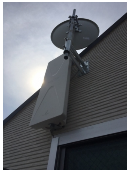
豊島区千早 ひかり建設様物件 壁面取付 デザインアンテナ工事
