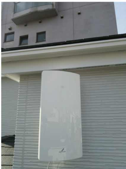
豊島区要町 壁面取付 デザインアンテナ工事
