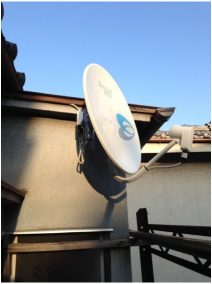
豊島区池袋本町 壁面取付 BSアンテナ工事
