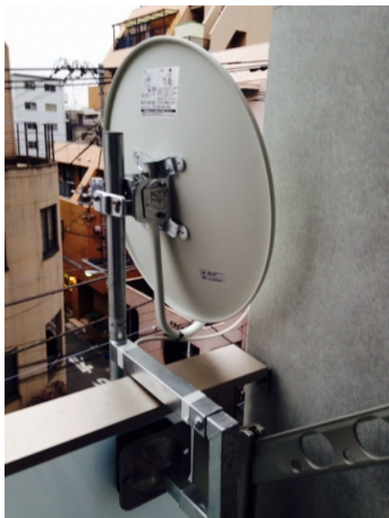
豊島区巣鴨 BSアンテナ挟み込み工事
