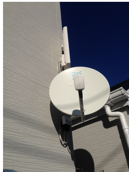
豊島区雑司ヶ谷 壁面取付 デザインアンテナとBS/CSアンテナ工事
