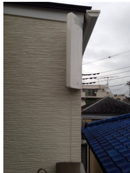
豊島区长崎 壁面取付 デザインアンテナ工事
