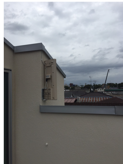
豊島区南池袋 シティーTOTALプラン様物件 壁面取付 デザインアンテナ工事
