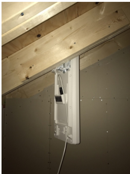
豊島区目白 住友不動産様物件 デザインアンテナ屋根裏工事
