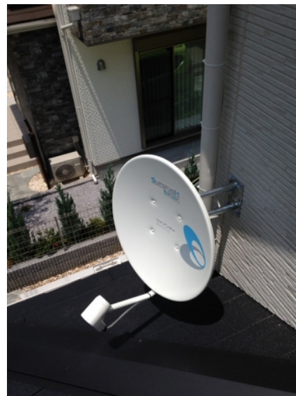
西東京市栄町 壁面取付 BSアンテナ工事
