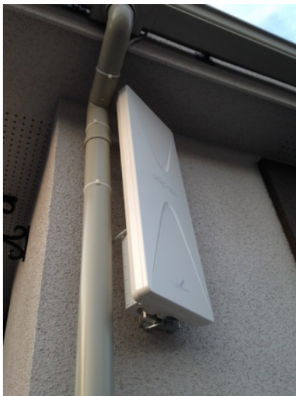
西東京市ひばりヶ丘北 壁面取付 デザインアンテナ工事
