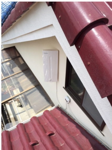
西東京市中町 壁面取付 デザインアンテナ工事
