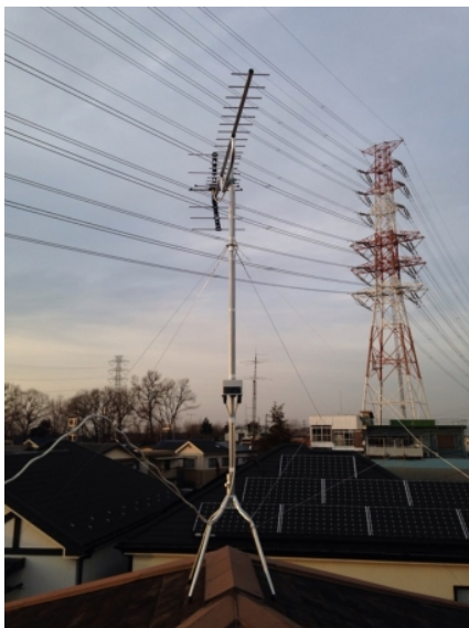
西東京市北町 地デジアンテナ屋根上工事
