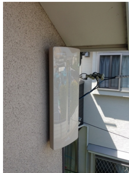
西東京市泉町 壁面取付 デザインアンテナ工事
