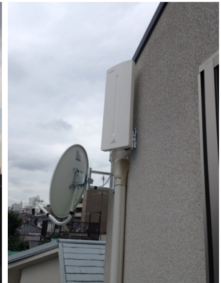
中野区南台 壁面取付 デザインアンテナとBSアンテナ工事
