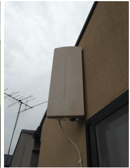
中野区鷺宮 壁面取付 デザインアンテナ工事
