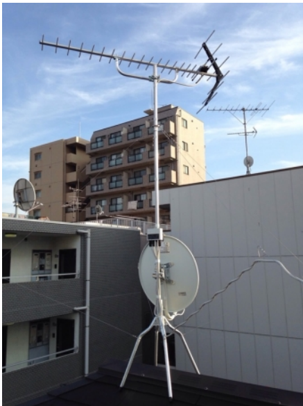
中野区南台 地デジアンテナとBSアンテナ屋根上工事
