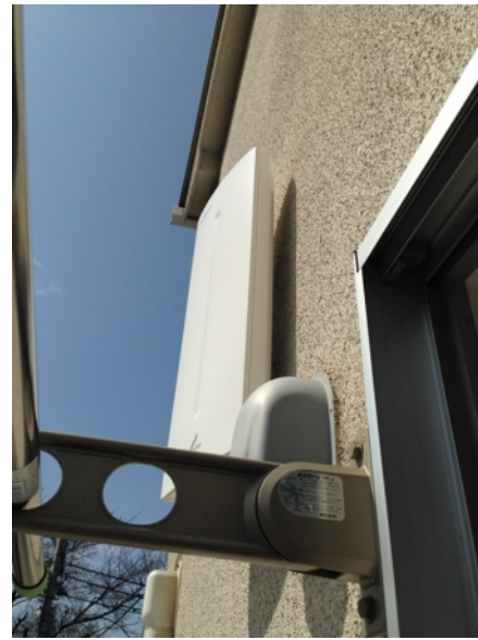
中野区上鷺宮 壁面取付 デザインアンテナ工事
