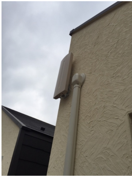
中野区中野 壁面取付 デザインアンテナ工事
