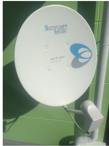
中野区大和町 壁面取付 BSアンテナ工事
