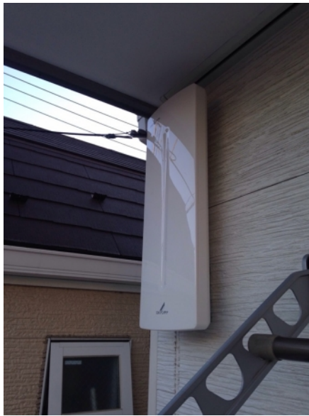
中野区中央 壁面取付 デザインアンテナ工事
