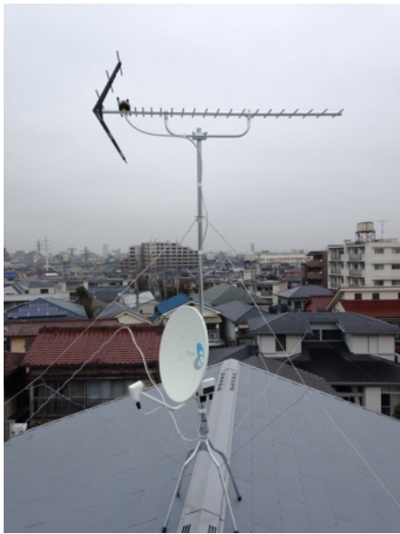
中野区野方 地デジアンテナとBSアンテナ屋根上工事
