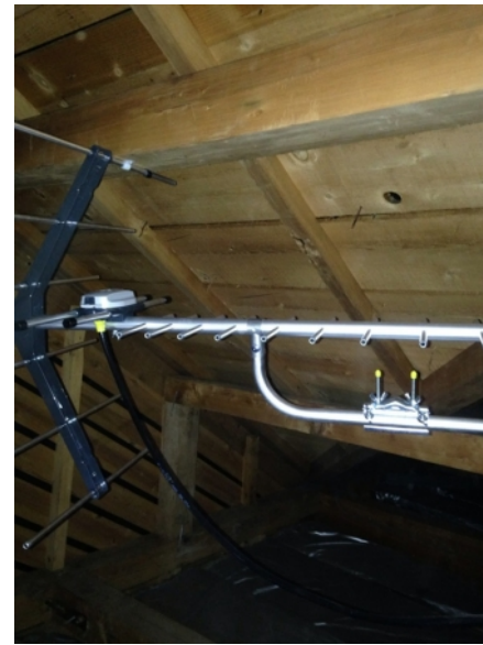
中野区沼袋 地デジアンテナ屋根裏工事
