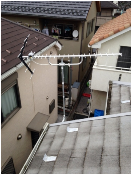
立川市砂川町 壁面取付 地デジアンテナ工事
