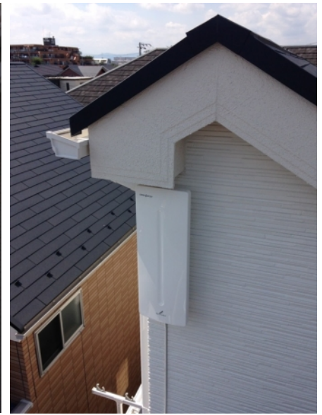
立川市幸町 壁面取付 BSアンテナ工事
