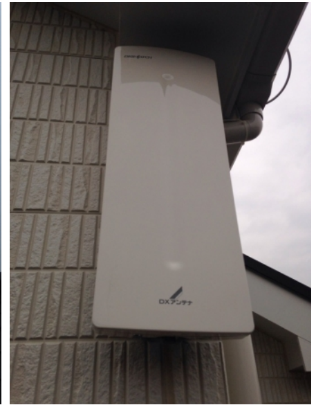
立川市羽衣町 壁面取付 デザインアンテナ工事
