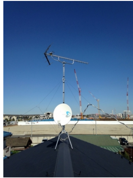
立川市高松町 地デジアンテナとBSアンテナ屋根上工事
