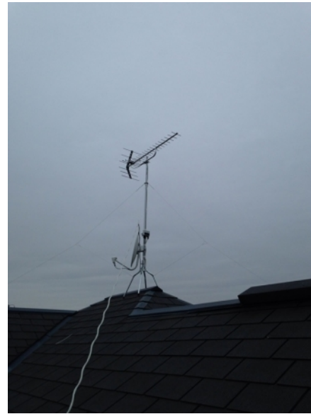
立川市幸町 地デジアンテナとBSアンテナ屋根上工事
