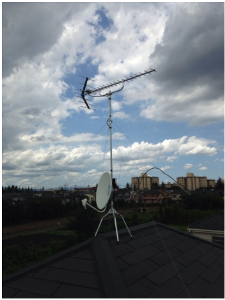
立川市西砂町 地デジアンテナとBSアンテナ屋根上工事
