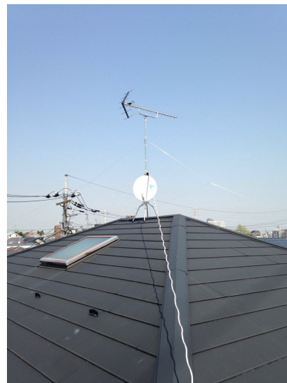
杉並区永福 地デジアンテナとBSアンテナ屋根上工事
