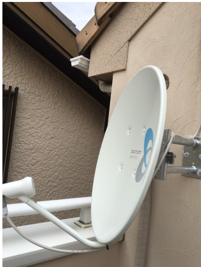
杉並区西荻南 壁面取付 B S アンテナ工事
