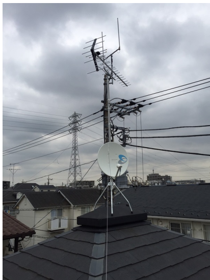
杉並区宮前 地デジアンテナとBSアンテナ屋根上工事
