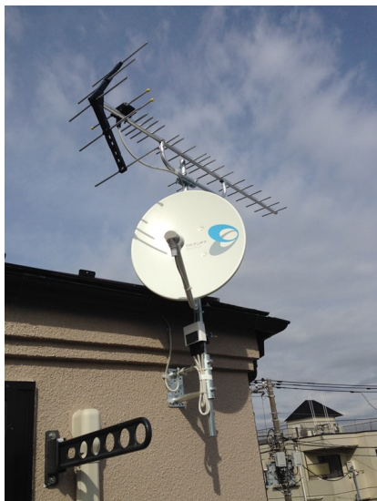
杉並区阿佐谷南 壁面取付 地デジアンテナとBSアンテナ工事
