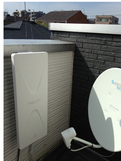
杉並区高円寺北 壁面取付 デザインアンテナとBSアンテナ工事
