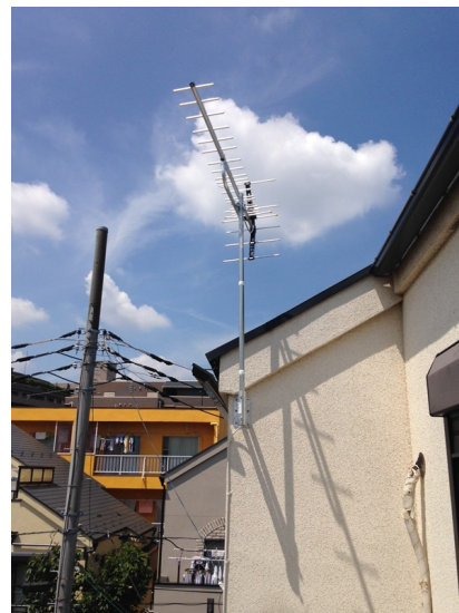
杉並区上高井戸 壁面取付 地デジアンテナ工事
