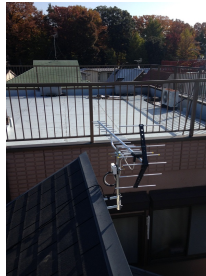
杉並区堀ノ内 壁面取付 地デジアンテナ工事
