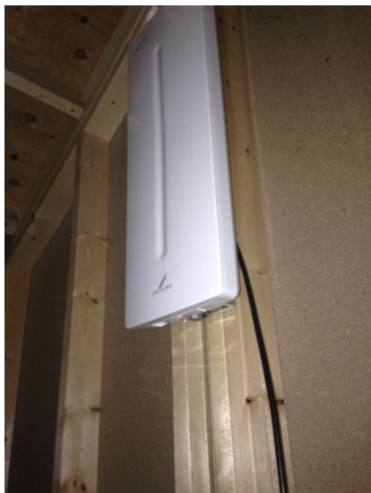
杉並区堀ノ内 デザインアンテナ屋根裏工事
