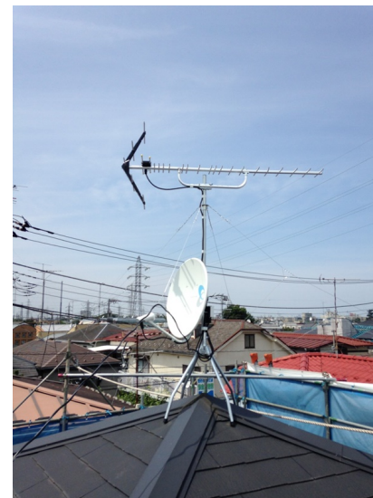
杉並区和泉 地デジアンテナとBSアンテナ屋根上工事
