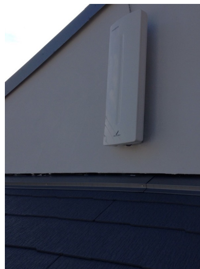
杉並区高井戸西 壁面取付 デザインアンテナ 工事
