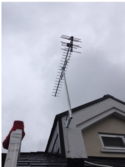
杉並区下井草 壁面取付 地デジアンテナ工事
