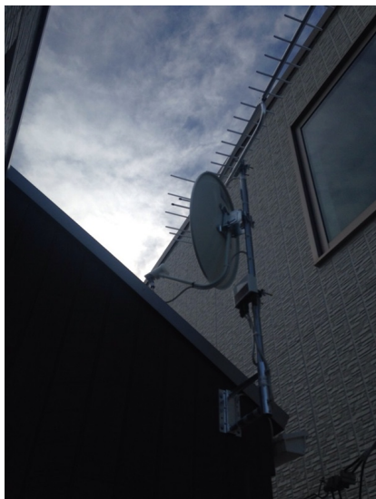
杉並区今川 壁面取付 地デジアンテナとBSアンテナ工事
