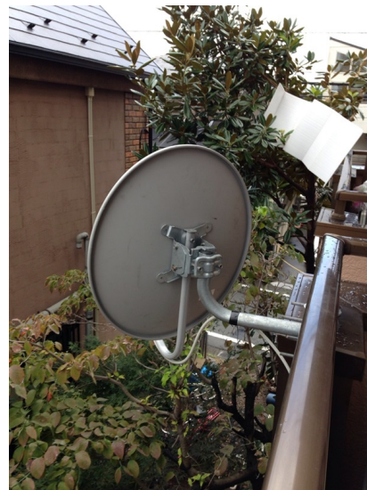
杉並区桃井 バランダ取付 BSアンテナ工事
