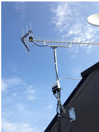
杉並区桃井 壁面取付 地デジアンテナ工事
