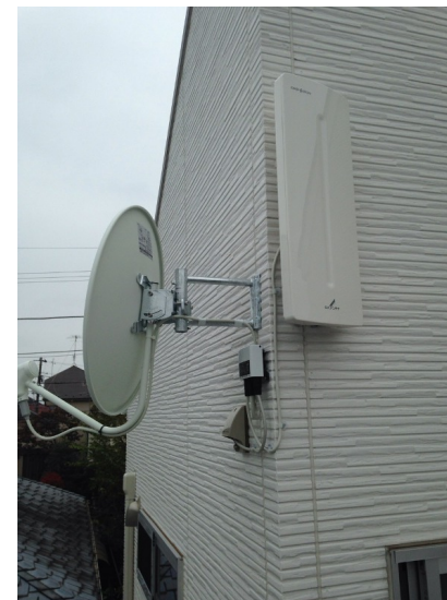
杉並区宮前 壁面取付 デザインアンテナとBSアンテナ工事
