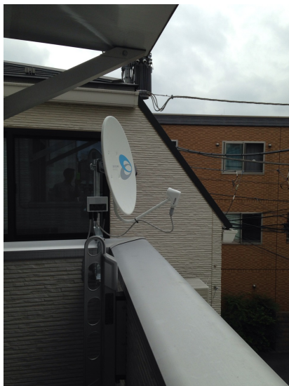
杉並区天沼 壁面取付 BSアンテナ工事
