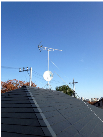
杉並区萩窪 地デジアンテナとBSアンテナ屋根上工事
