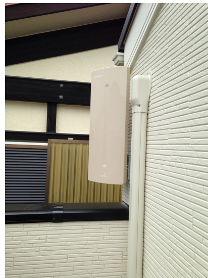
杉並区方南 壁面取付 地デジアンテナ工事
