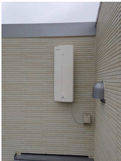
杉並区方南 オープンハウス様物件 壁面取付 デザインアンテナ工事
