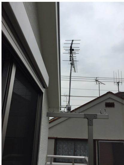
杉並区本天沼 飯田産業様物件 壁面取付 地デジアンテナ工事
