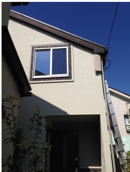
杉並区本天沼 飯田産業様物件 地デジアンテナ工事後の外観
