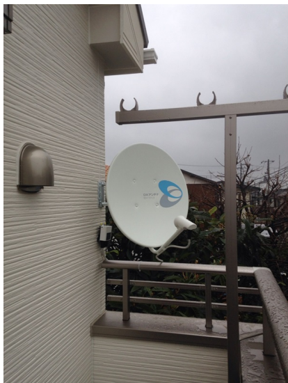
杉並区和泉 誠和不動産様物件 地デジアンテナ壁面工事
