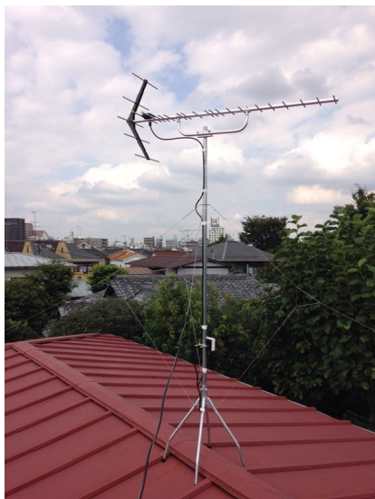
杉並区成田東 誠和不動産様物件 地デジアンテナ屋根上工事
