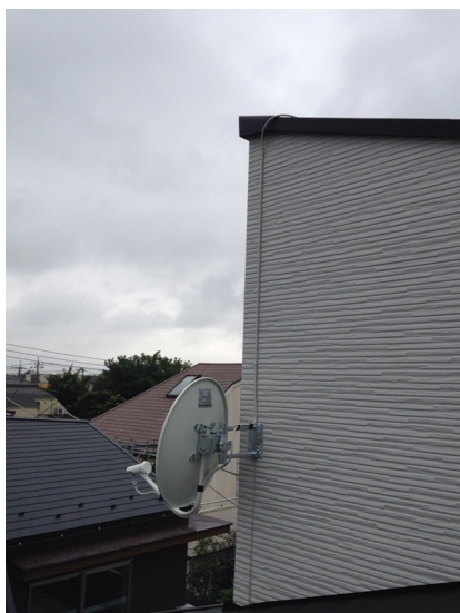
杉並区南荻窪 藤和ハウス様物件 壁面取付 BSアンテナ工事
