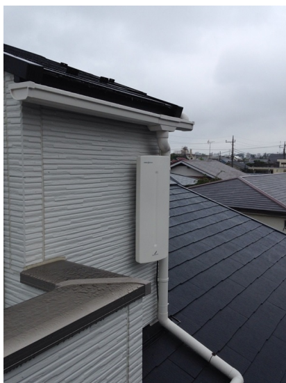
杉並区南荻窪 藤和ハウス様物件 壁面取付 デザインアンテナ工事
