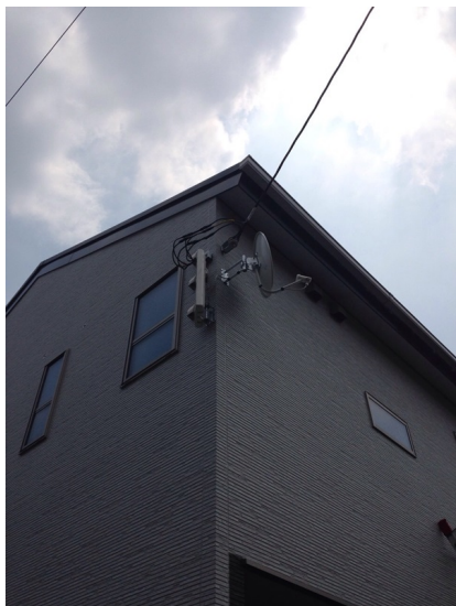
杉並区高円寺北 新築そっくりさん様物件 デザインアンテナとBSアンテナ工事後の外観
