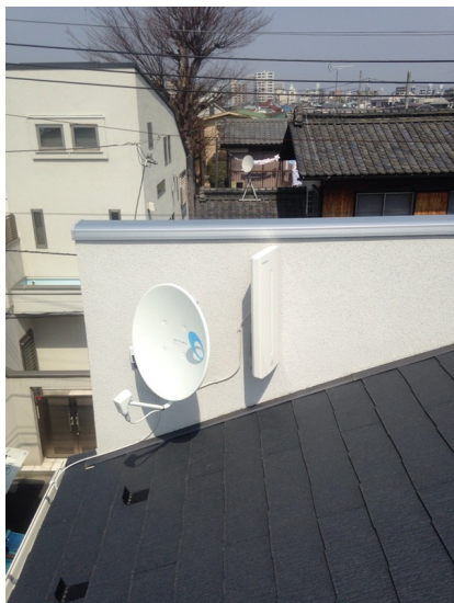
杉並区成田東 ライフプランニング様物件 壁面取付 デザインアンテナとBSアンテナ工事
