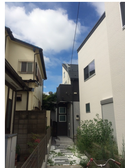
杉並区本天沼 三栄建設様物件 地デジアンテナ工事後の外観
