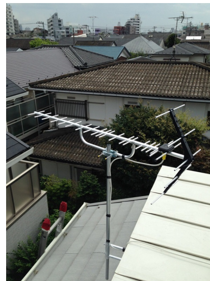
杉並区阿佐谷北 エムエルクリエイイト様物件 地デジアンテナ屋根裏工事
