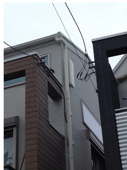
杉並区和泉 小野建設様物件 壁面取付 デザインアンテナ工事
