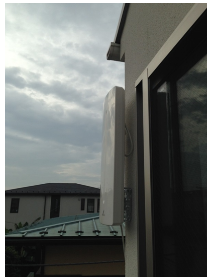
杉並区梅里 東勝様物件 壁面取付 デザインアンテナ工事
