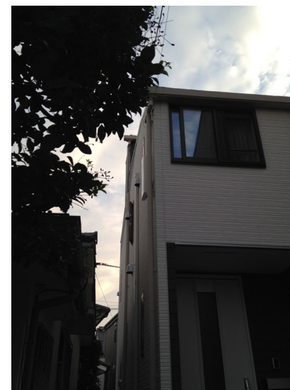
杉並区西荻北 オープンハウス様物件 デザインアンテナ工事後の外観
