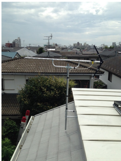
杉並区善福寺 一条工務店様物件 壁面取付 地デジアンテナ工事
