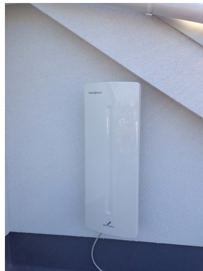
杉並区西萩南 東勝建設様物件 壁面取付 デザインアンテナ工事
