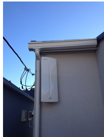
杉並区高井戸台 ライフハウジング様物件 壁面取付 デザインアンテナ工事
