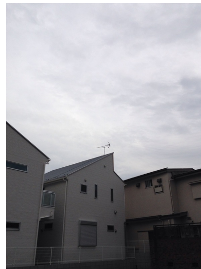
杉並区成田西 檀設計事務所様物件 地デジアンテナとBSアンテナ工事後の外観
