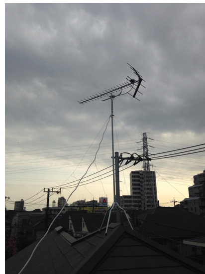
杉並区上高井戸 細田工務店様物件 地デジアンテナ屋根上工事
