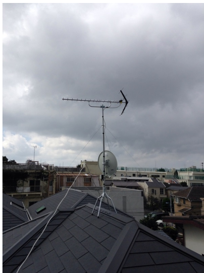
杉並区本天沼 タクトホーム様物件 地デジアンテナとBSアンテナ屋根上工事
