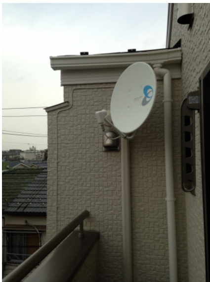
新宿区上落合 壁面取付 BSアンテナ工事
