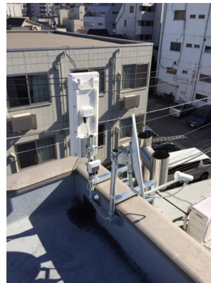
新宿区百人町 デザインアンテナとBSアンテナ挟み込み工事
