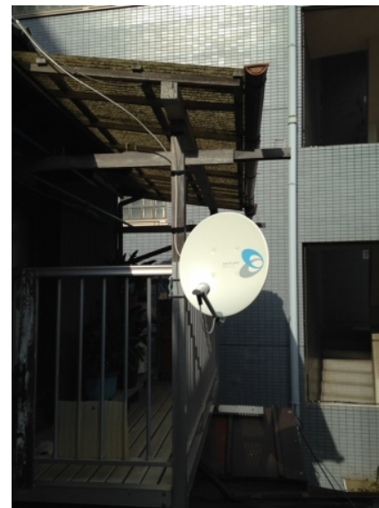
新宿区高田馬場 ベランダ取付 B S アンテナ工事
