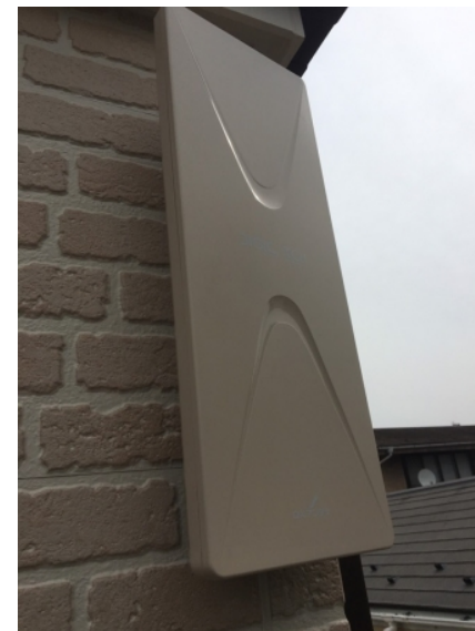
新宿区北新宿 壁面取付 デザインアンテナ工事
