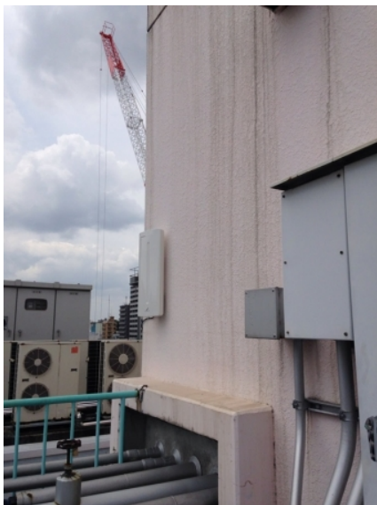
新宿区下落合 壁面取付 デザインアンテナ工事
