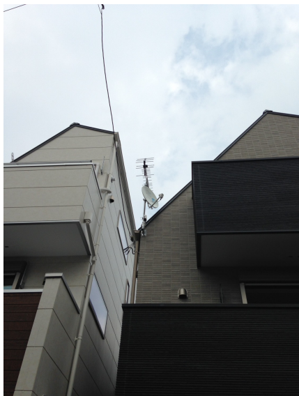
新宿区上落合 BLISS様物件 壁面取付 地デジアンテナとBSアンテナ工事
