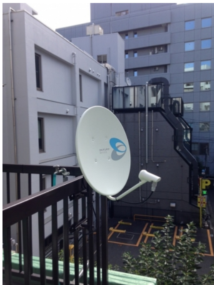
新宿区揚場町 フェンス取付 B S アンテナ工事
