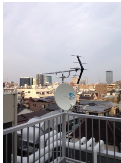
新宿区天神町 地デジアンテナとBSアンテナ工 事
