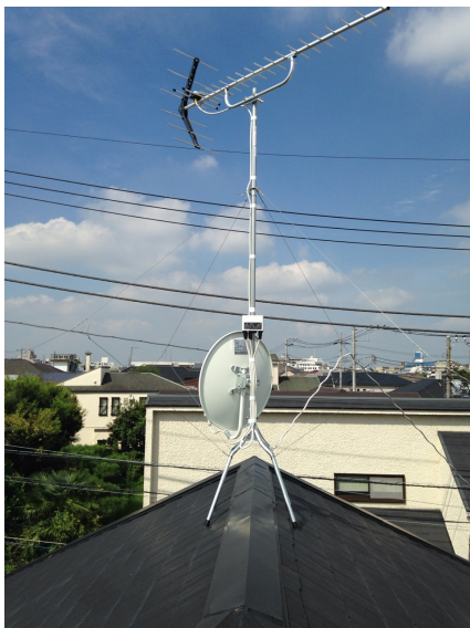
品川区旗の台 地デジアンテナとBSアンテナ屋根上工事
