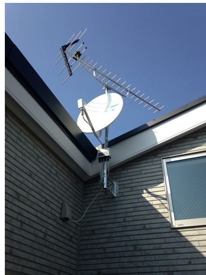
品川区大井 地デジアンテナ屋根上工事
