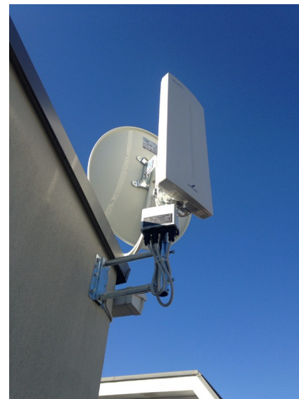
品川区西品川 壁面取付 デザインアンテナとBSアンテナ工事
