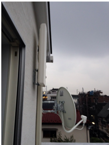
品川区西大井 壁面取付 デザインアンテナとBSアンテナ工事
