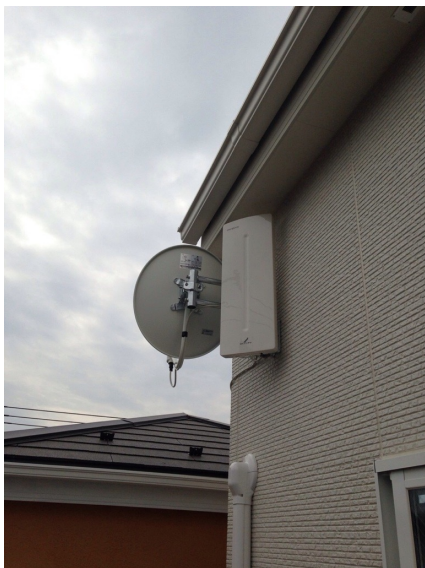
品川区小山 壁面取付 デザインアンテナとBSアンテナ工事
