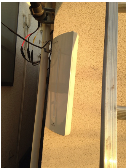
品川区大井 壁面取付 デザインアンテナ工事
