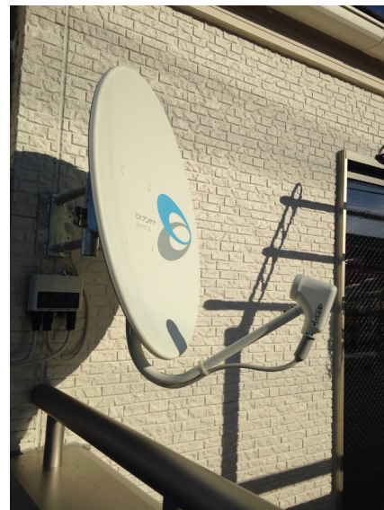
品川区中延 壁面取付 BSアンテナ工事
