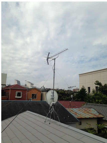
品川区東五反田 地デジアンテナとBSアンテナ屋根上工事
