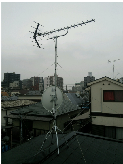
品川区荏原 地デジアンテナとBSアンテナ屋根上工事
