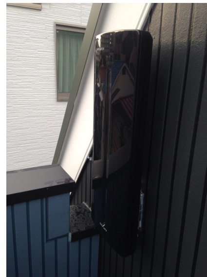
品川区南品川 壁面取付 デザインアンテナ工事
