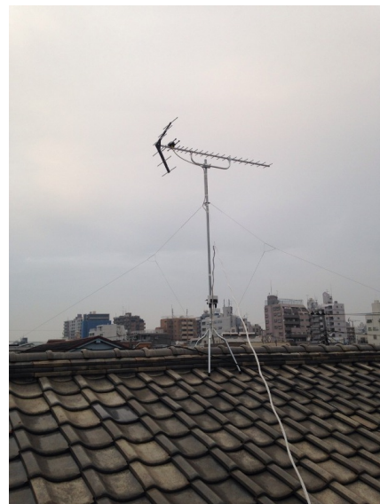
品川区荏原 地デジアンテナ屋根上設置
